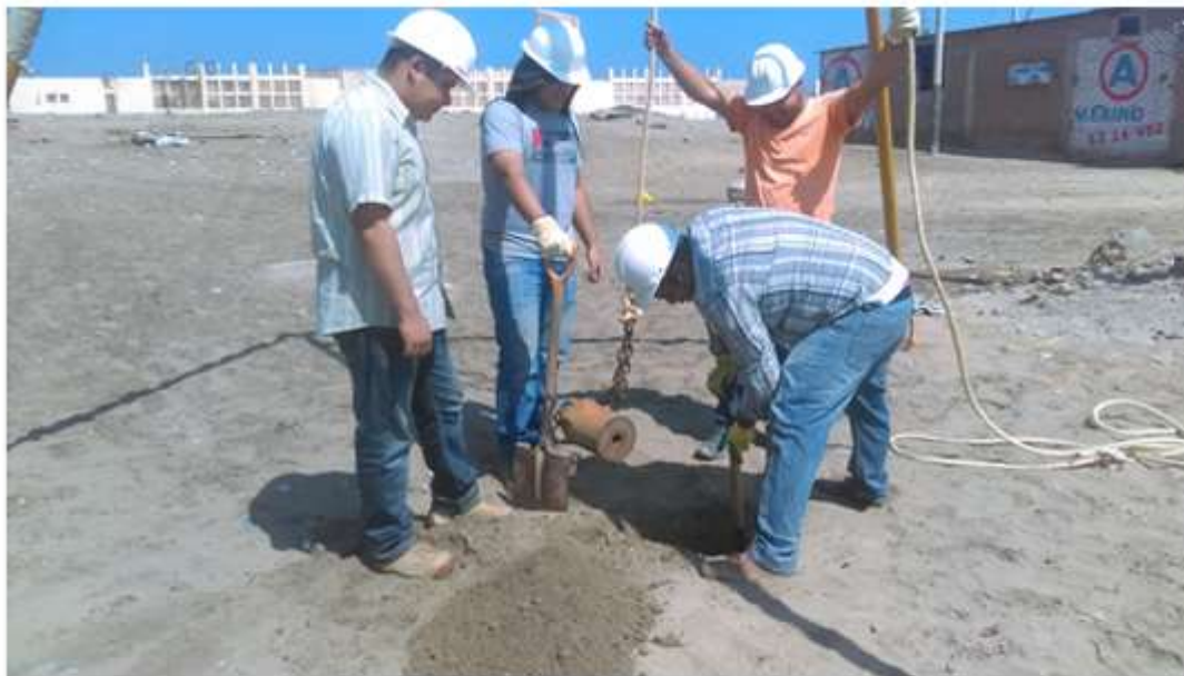
Figura 32: Excavación del terreno hasta 1m de profundidad para iniciar el hincado en el SPT-1
