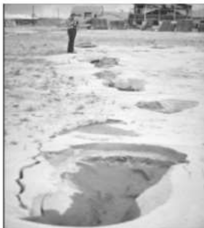
Figura 15. Asentamientos causados por la licuación durante el sismo de Niigata, Japón 1964.
