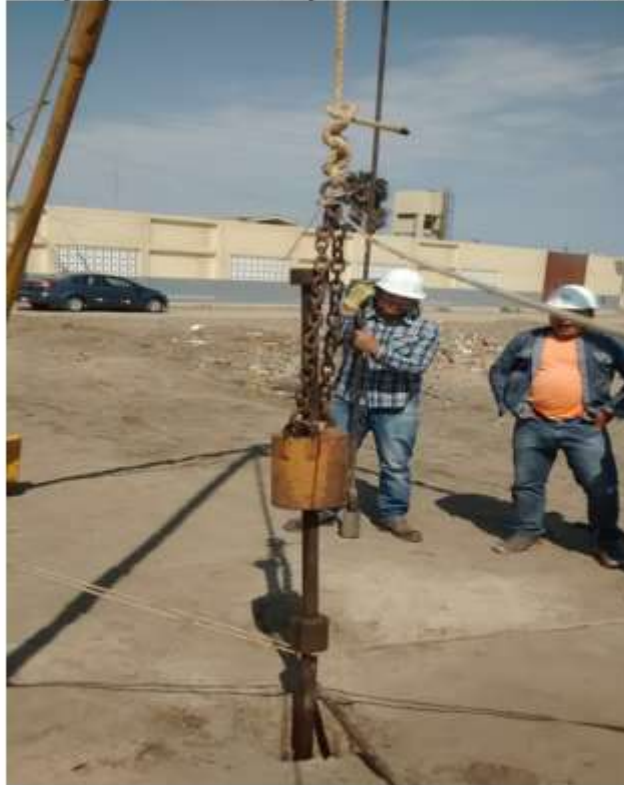
Figura 34: hincado del SPT- 4 Fuente: Propia
