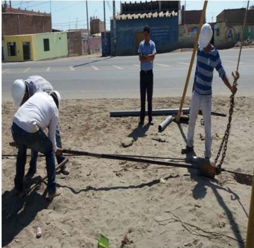
Figura 42: extracción de la caña para obtener la muestra del SPT-7 Fuente: Propia
