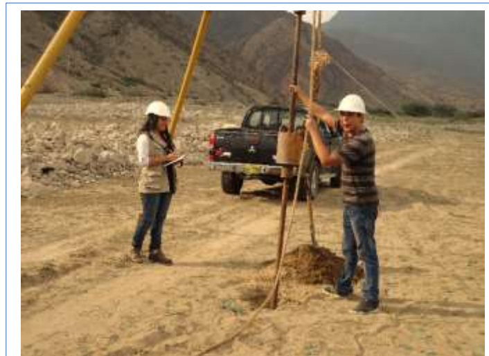
Figura 23: Muestreo con SPT (Coordenadas UTM - E: 703.143 / N: 9'201.425).
