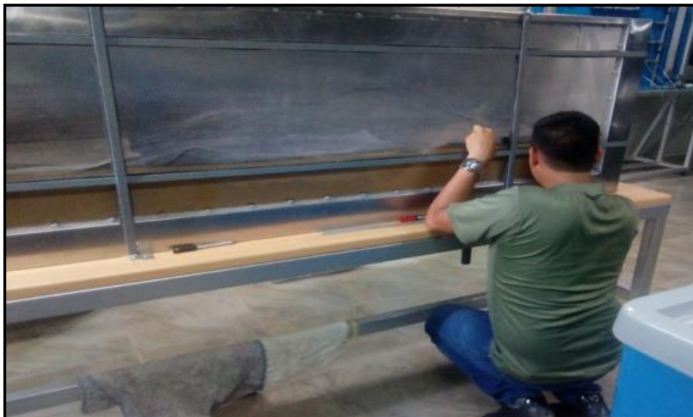
Figura 213. Replanteo de la nueva sección de presa (2do predimensionamiento) en la pantalla acrílica.
