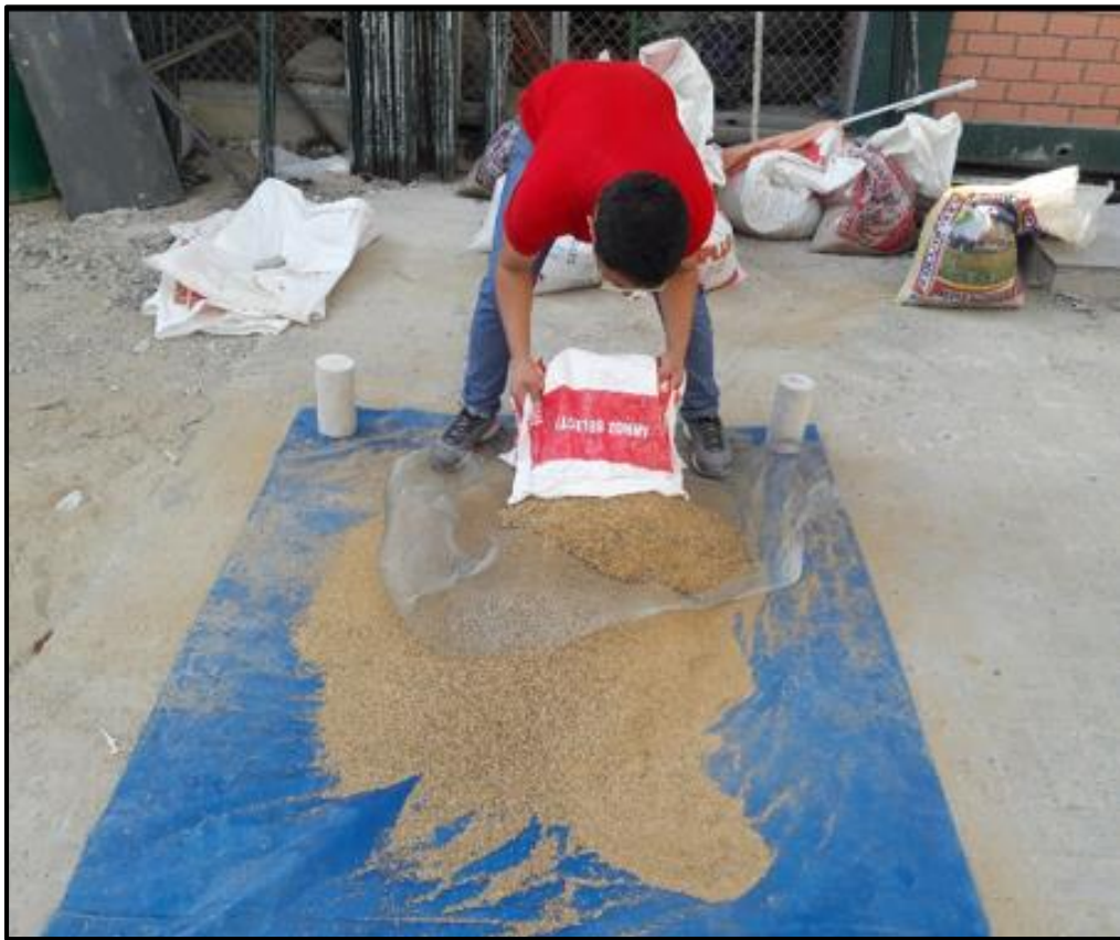
Figura 46. Tamizado de la arena gruesa con malla metálica de \frac{1}{4} ".
