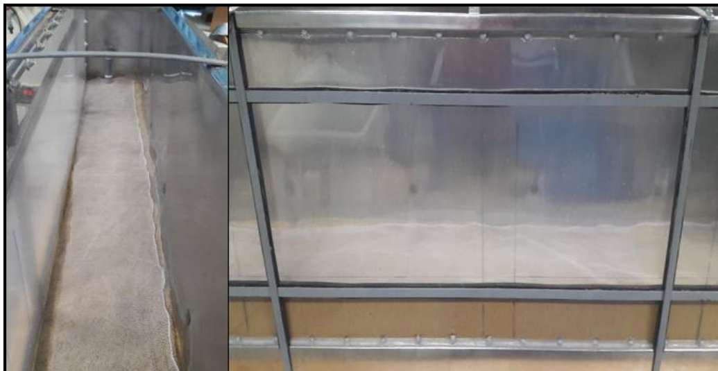
Figura 207. Colocación de la malla de tela plástica (entre los estratos de la cimentación).
