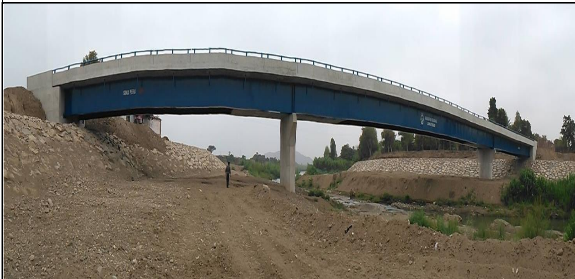
Figura 4: Puente Pucalá – vista de la sección principal.
