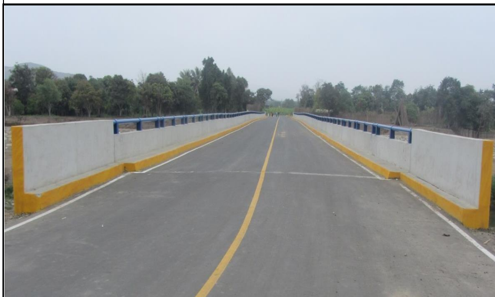
Figura 5: Puente Pucalá - vista de carpeta asfáltica.
