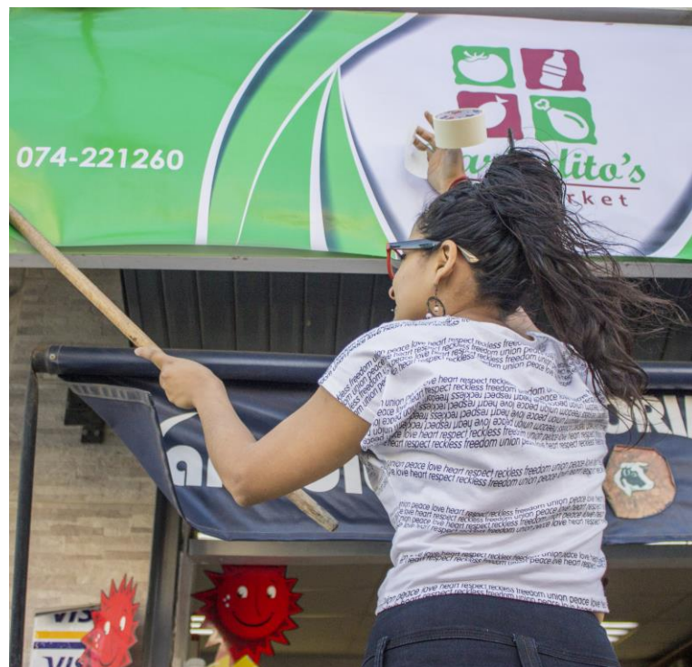
COLOCACIÓN DEL NUEVO LETRERO
