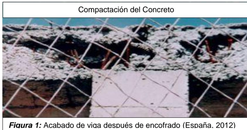
Un hormigón fresco después de mezclado, amasado, transportado y vertido contiene aire ocluido en torno a un 20%, por este motivo es necesario vibrar el hormigón con el fin de dejarlo en torno a un 1%. Este aire ocluido como no está directamente relacionado con la trabajabilidad del hormigón: no tendrá el mismo un hormigón de consistencia seca que uno de consistencia blanda.
