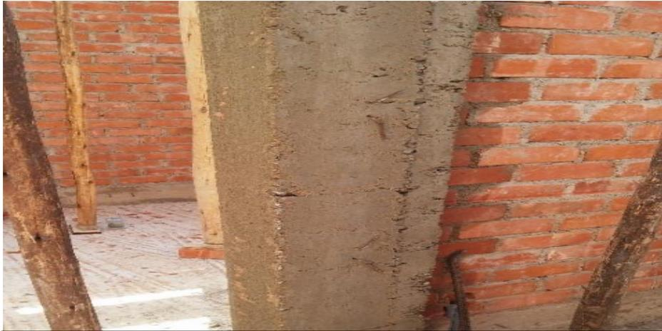
**Figura 2:** Columna con presencia de cangrejas. **Obra:** Edificación de vivienda de 3 plantas, Cl. Ollantay cuadra #2, La Victoria, Chiclayo.
