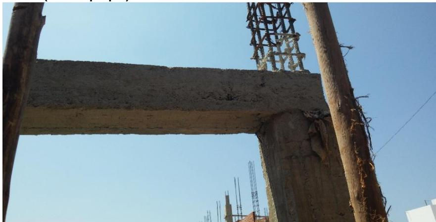
**Figura 3:** Viga con presencia de cangrejas. **Obra:** Edificación de vivienda, cl. Las Nustas #5, La Victoria, Chiclayo.
