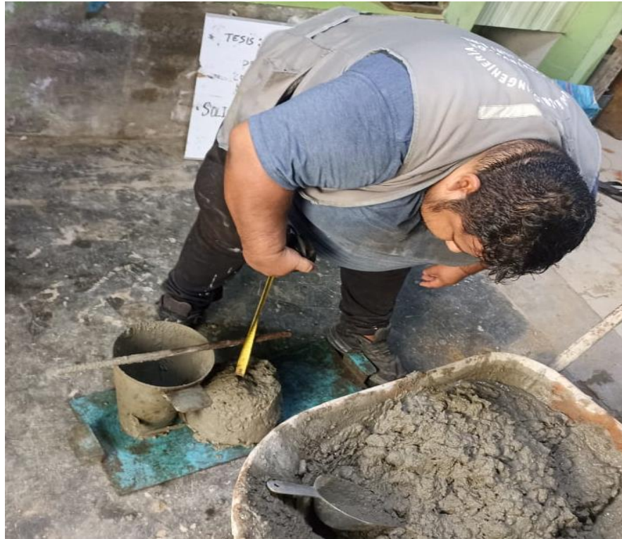
FOTO 13: Prueba del Slump.
