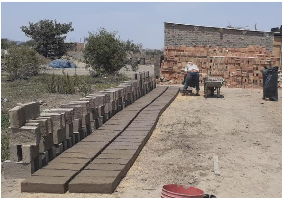
**Fig.18.** Moldeado y puesto a secado de adobes.
