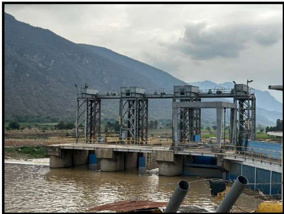
Vista de la bocatoma Racarrumi donde está ubicada la regla gradual
