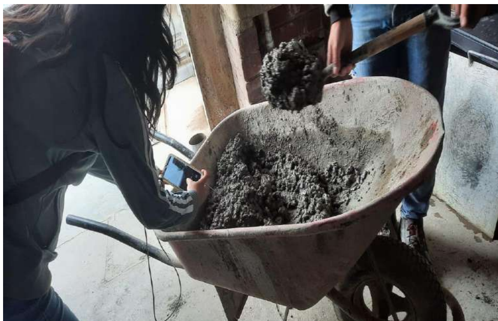
Fig. 19 Elaboración del concreto patrón f'c = 210 \text{ kg/cm}^2 y f'c = 280 \text{ kg/cm}^2
