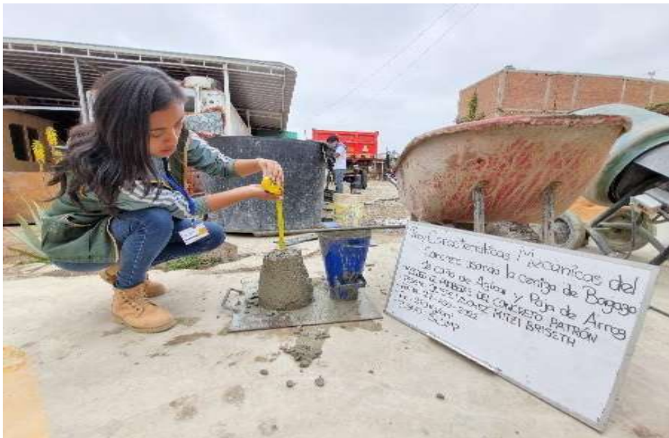
Fot 12. Proceso de la elaboración de mezcla y ensayo de Slump
