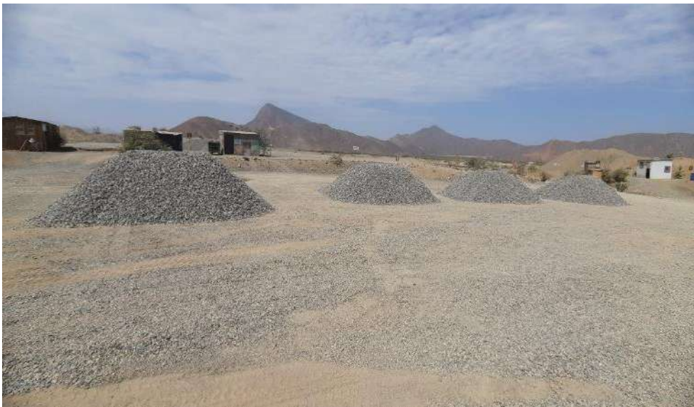
Fig. 10 Acopio de material.
