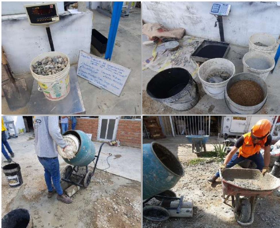
Fotografía 33: Preparación de mezcla.
