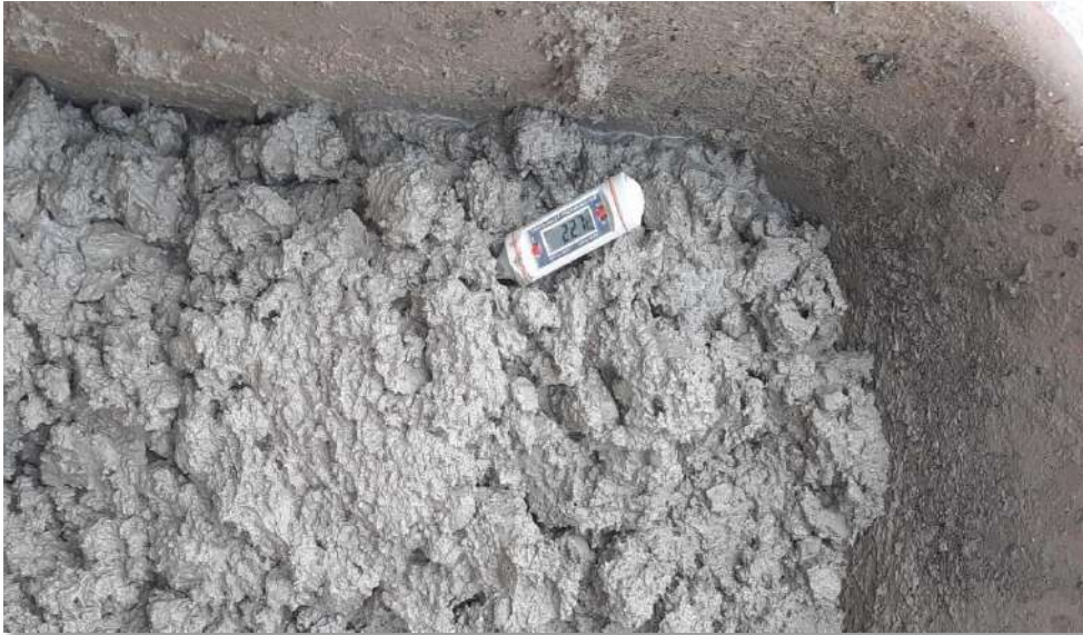
Fig. 26. Medición de temperatura a mezcla de concreto.
