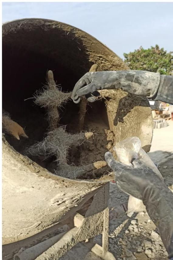
Foto 8: Preparación del concreto con CCM y FS.
