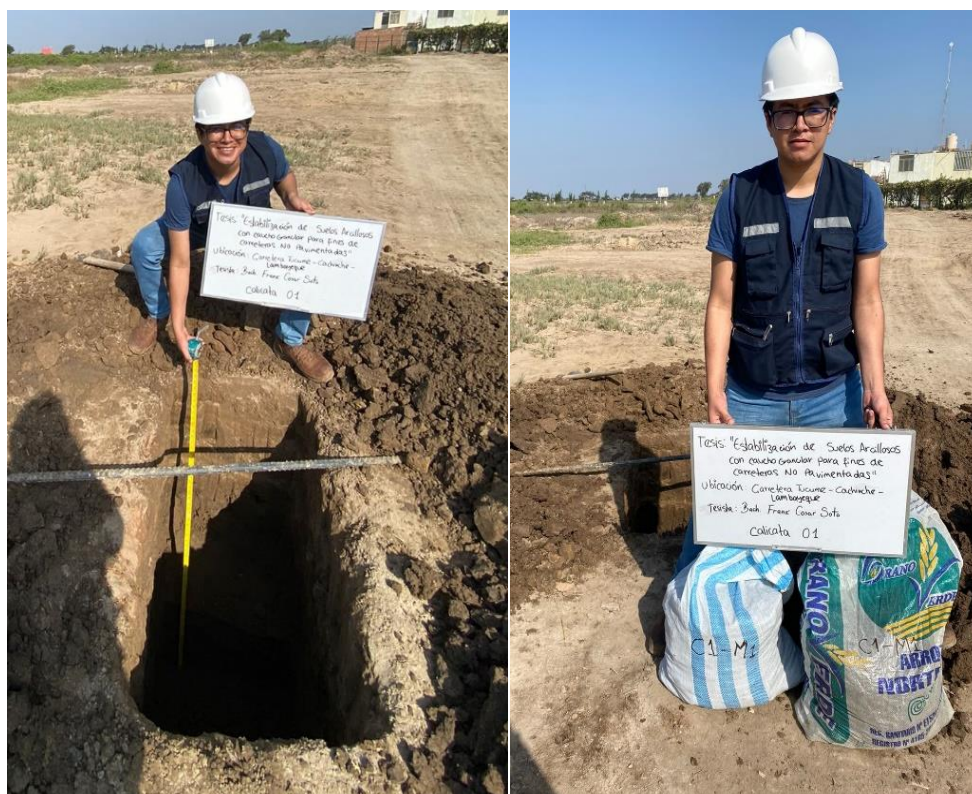
Fig. 2. Excavación calicata 01 y extracción de muestras
