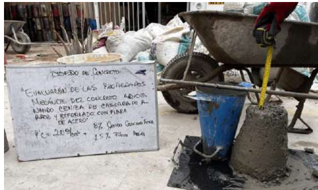
Fotografía 7. Medición del asentamiento
