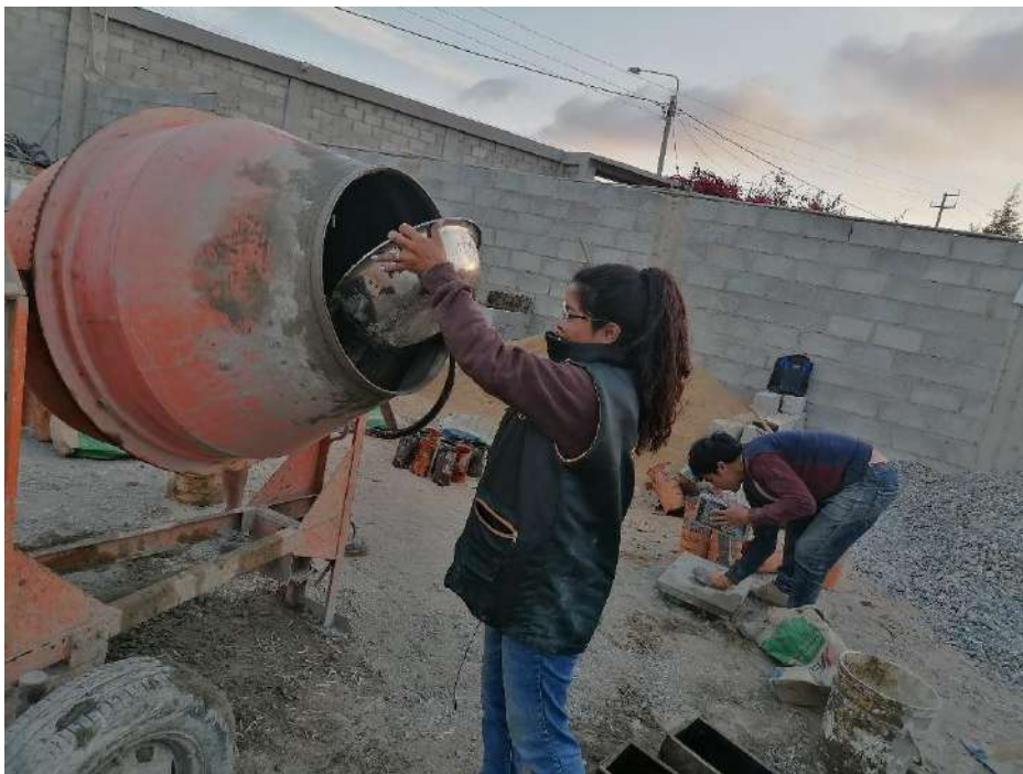
Fotografía 10. Vaciado de la Fibra de Nailon a la mezcla del concreto
