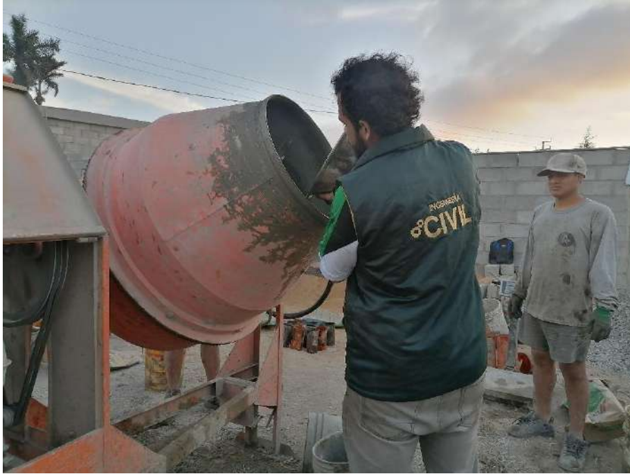
Fotografía 9. Vaciado del Polvo de Mármol a la mezcla del concreto
