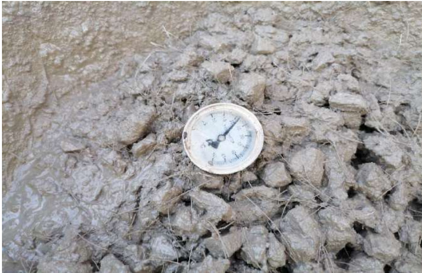
Fotografía 11. Ensayo de temperatura del concreto en estado fresco
