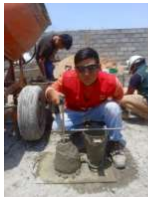
Fig. 11. Asentamiento o Slump que mide la trabajabilidad.
