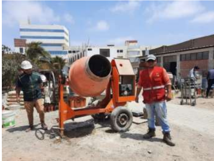
Fotografía 13 Maquina mezcladora (Trompo) para obtención de concreto.
