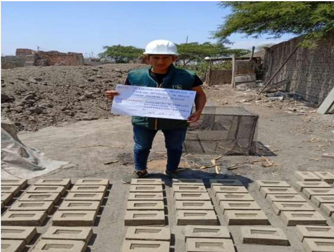
Anexo 2.10: moldeado y secado de las unidades de albañilería con sus respectivos porcentajes.
