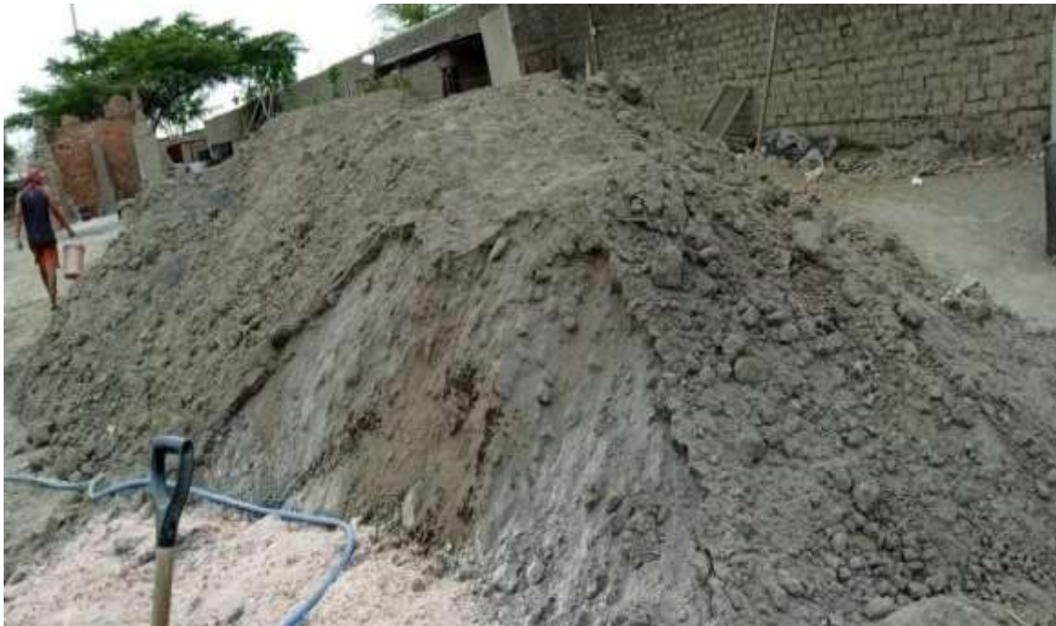
Anexo 2.4: concentración de todos los elementos para obtener una mezcla homogénea para la elaboración de las unidades de albañilería artesanal
