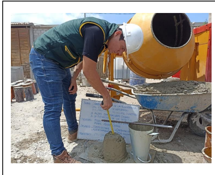
Fig 16: Medición del Slump del concreto
