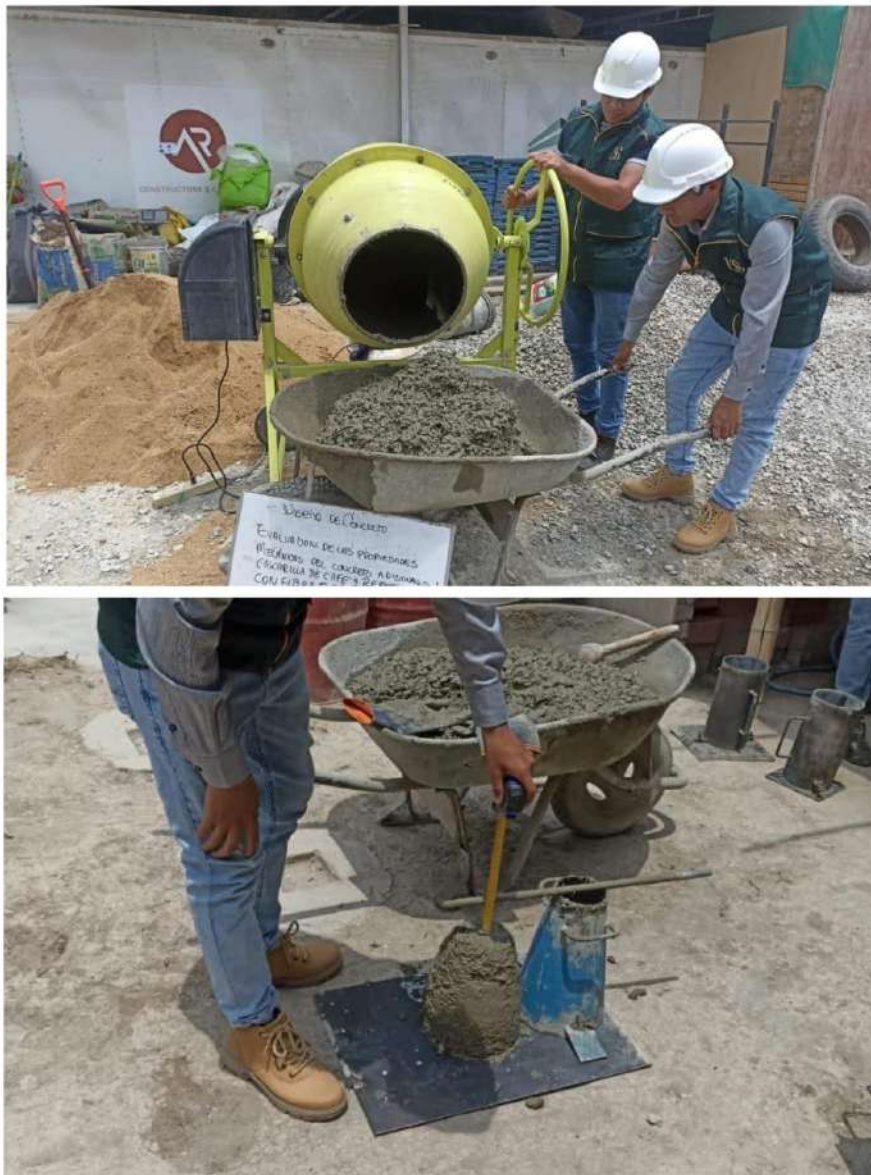
Fig. 45. Preparación de la mezcla de concreto y Slump.
