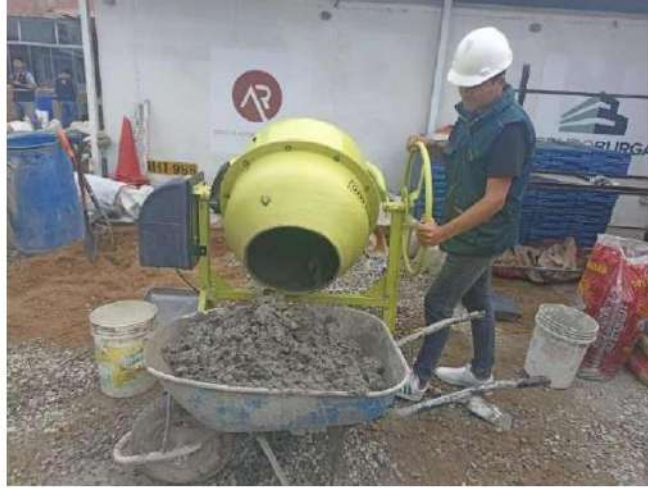
Vaciado de mezcla de concreto con adición de ceniza para proceder a la realización del llenado de testigos
