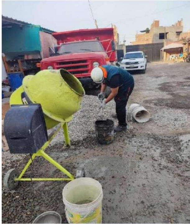
Incorporación de agregado grueso al trompo para la realización de concreto con fibra de polipropileno
