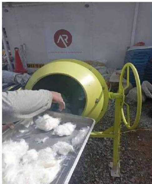
Incorporación de fibra de polipropileno a la mezcla de concreto
