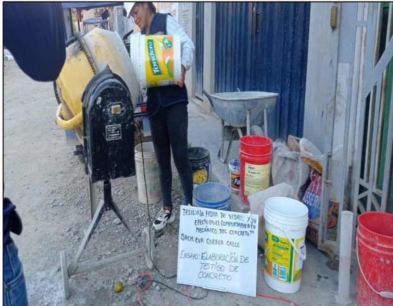
Figura 52: Realización de la mezcla del concreto Patrón 210 kg/cm 2 y 280 kg/cm 2 + adición de 0.5%, 1%, 2%, 3% de fibra de vidrio
