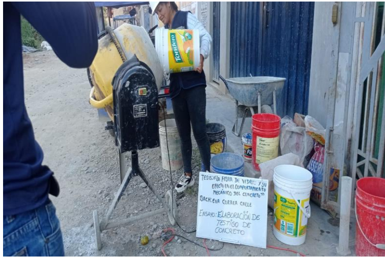
Fig.23. Elaboración de testigos de concreto
