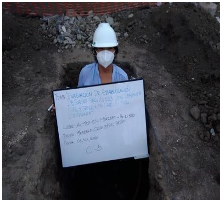
Fig 16: calicata C-05 (1+000) Av. México Fuente: elaboración propia
