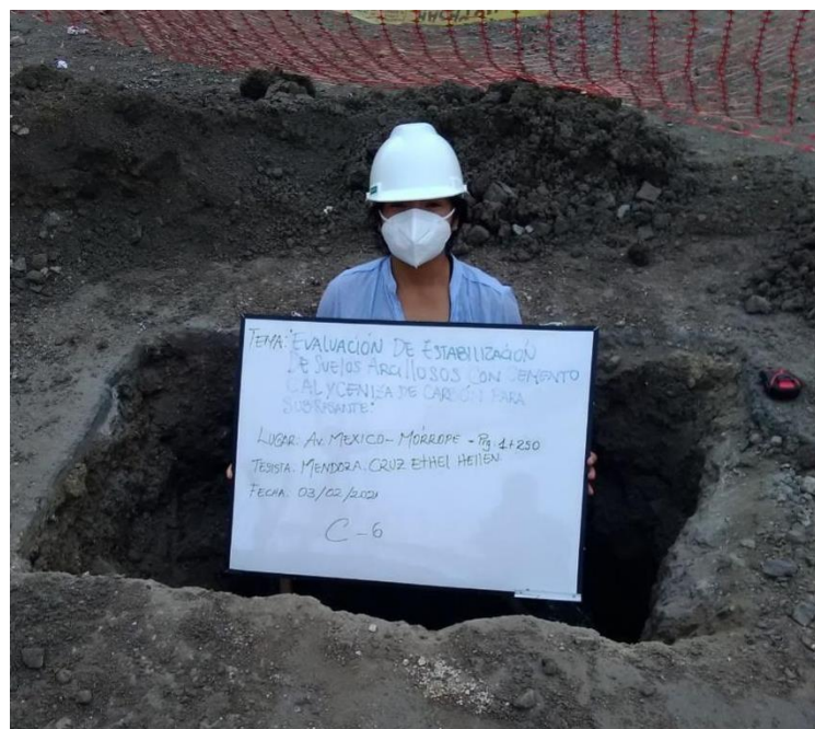
Fig 17: calicata C-06 (1+500) Av. México Fuente: elaboración propia
