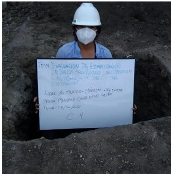
Fig 15: calicata C-04 (0+750) Av. México Fuente: elaboración propia
