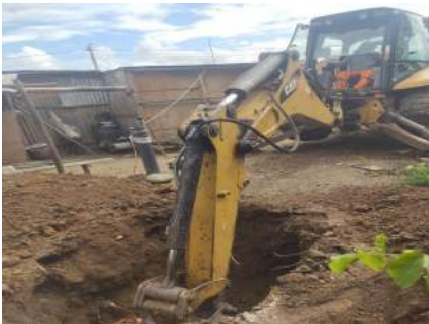
Fotografía 8: Extracción del suelo natural.
