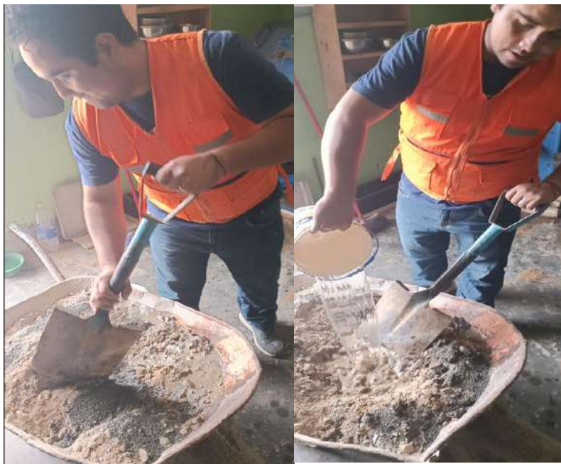
Fotografía 8. Combinación de los materiales para la elaboración del concreto
