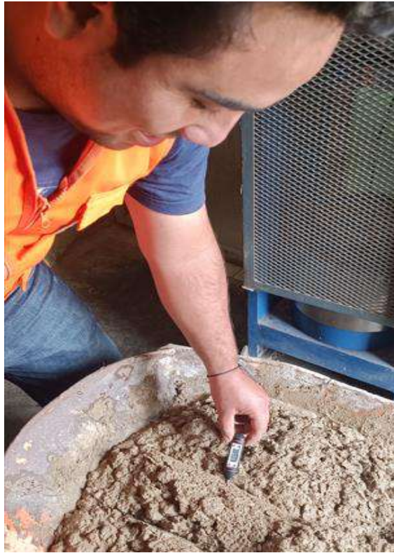
Fotografía 13. Temperatura del concreto
