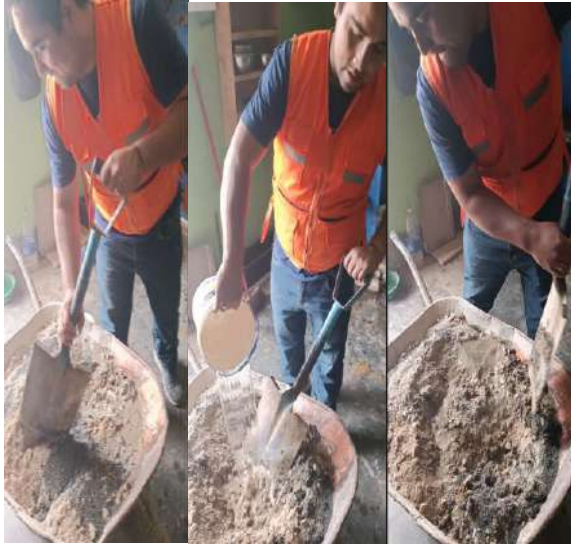
Fig. 12. Proceso de mezclado del concreto patrón y experimental
