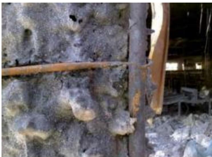
Fig. 3. Estribos de concreto armado expuesto al efecto de elevadas temperaturas. [23].
