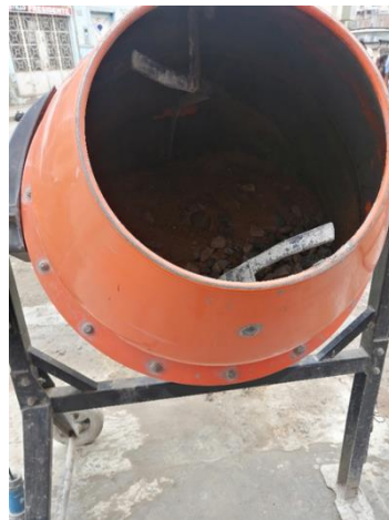
Fig 1. Mezclado del concreto
