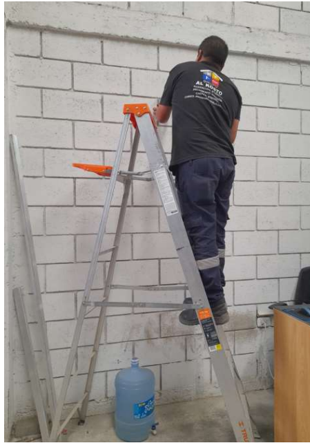
Fig. 43. Proceso de instalación de la pizarra
