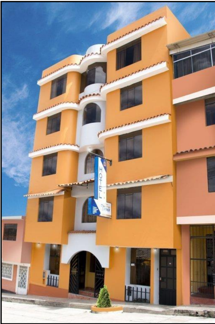
Figura 12 Foto de Fachada del Hotel Residencial Tamia
