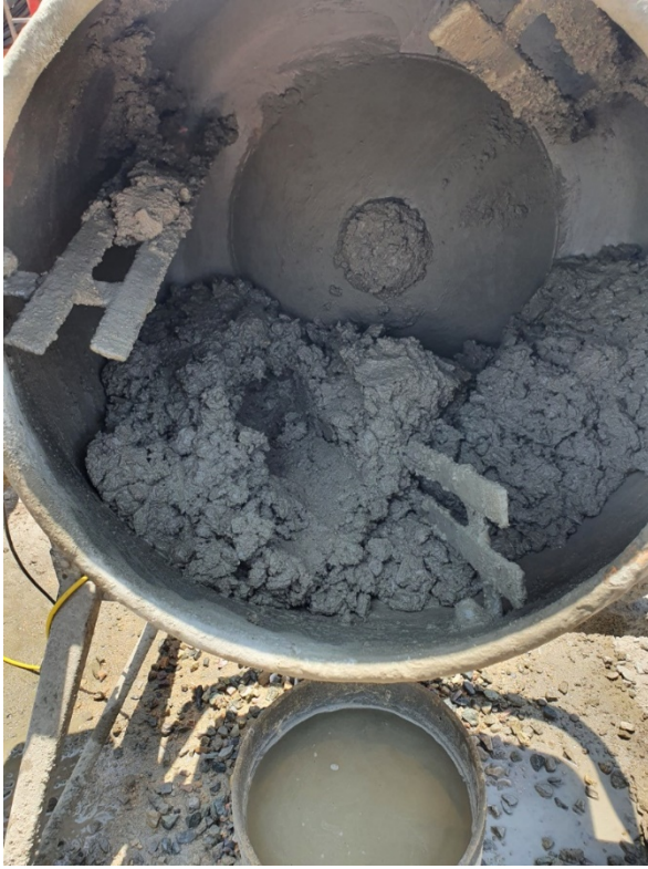
Fig. 15. Mezcla de concreto
