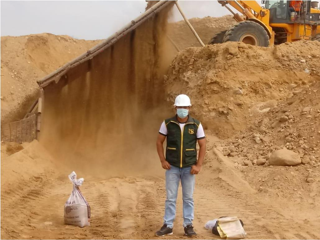
**Fig. 30.** Agregado fino extraído de la cantera “La Victoria”
