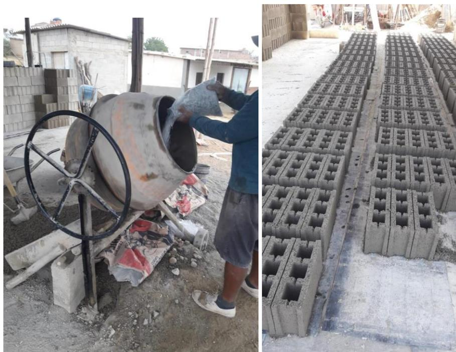
**Fotografía 6. Preparación de bloques de concreto experimentales**
