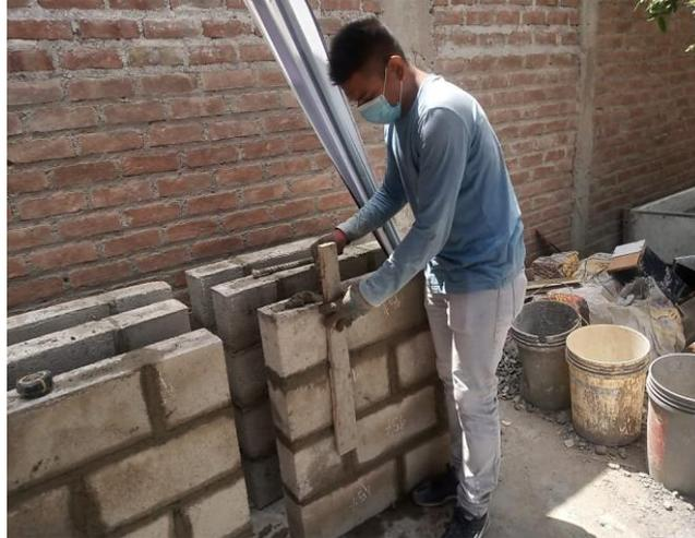
**Fig. 33.** Construcción de muretes con bloques.
