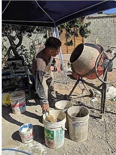
**Fig. 17.** Preparación de la mezcla de concreto.
