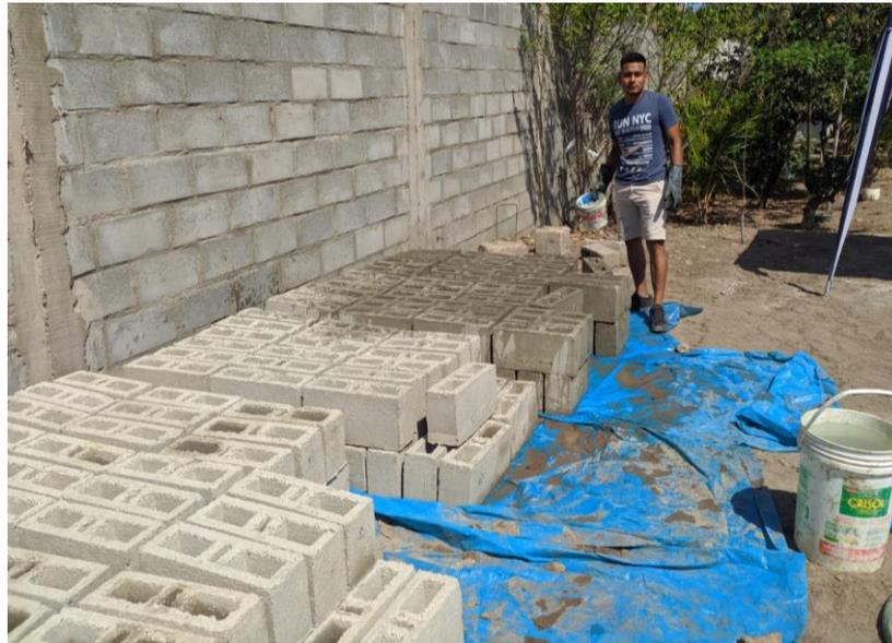
**Fig. 1.** Bloque de concreto tipo P elaborada in situ.
