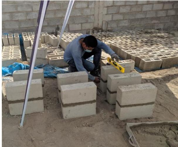
**Fig. 30.** Construcción de pilas de albañilería con bloques de concreto.
