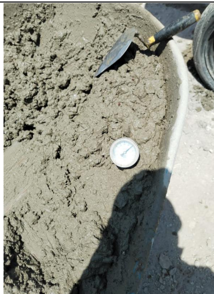
Fig. 29. Medición de temperatura del concreto
