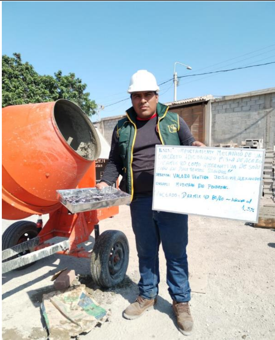
Fig. 25. Incorporación de fibras de acero Dramix 4D a la mezcla de concreto
