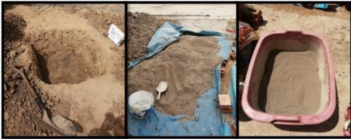
Figura 6. Selección y tamizado del suelo a utilizar
