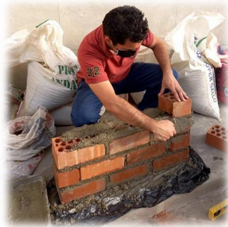
Fig. 14. Elaboración de muretes con barrera impermeabilizante en el mortero
