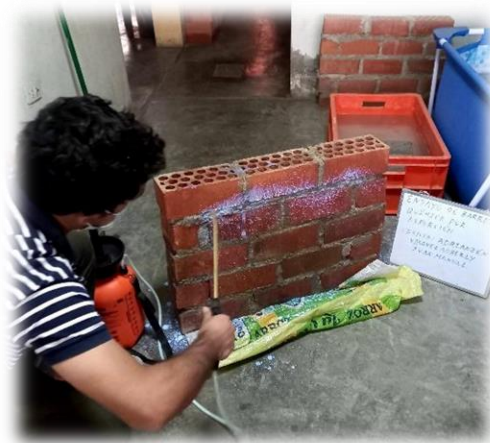
Fig. 12. Aplicación de barrera por aspersion
