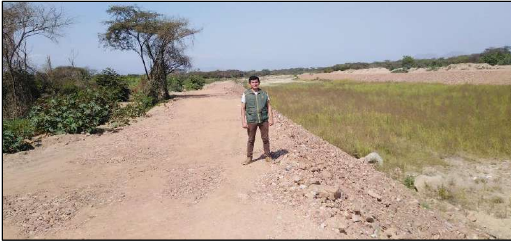
Fig. 1. Obras de encauzamiento del del Río La Leche
