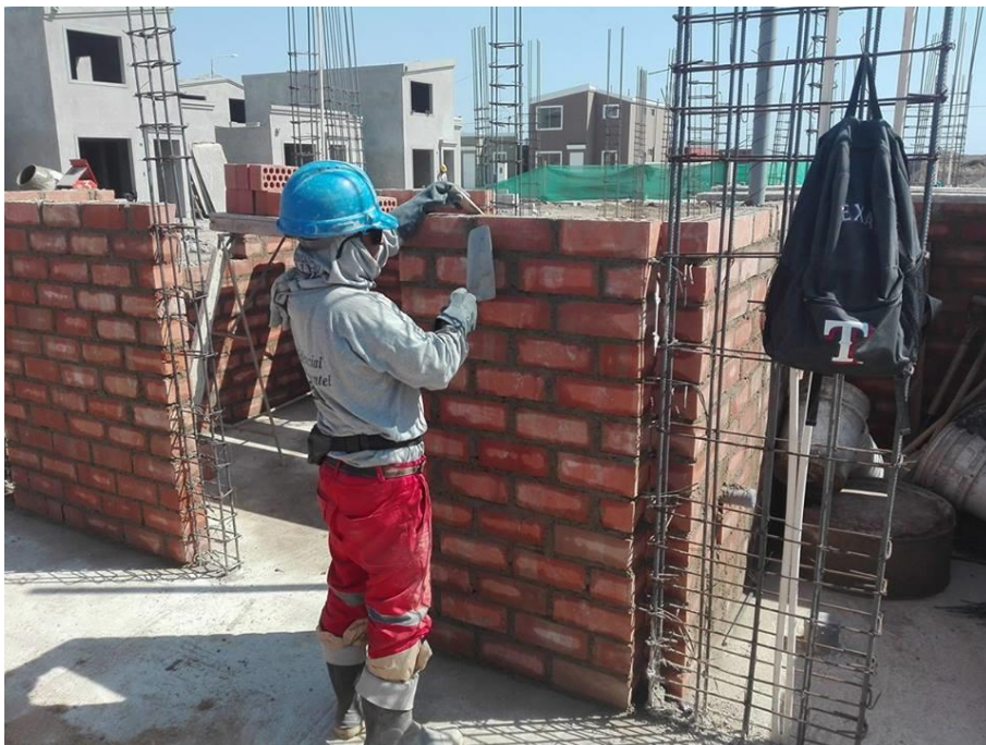
Fuente: Archivo de obra.
