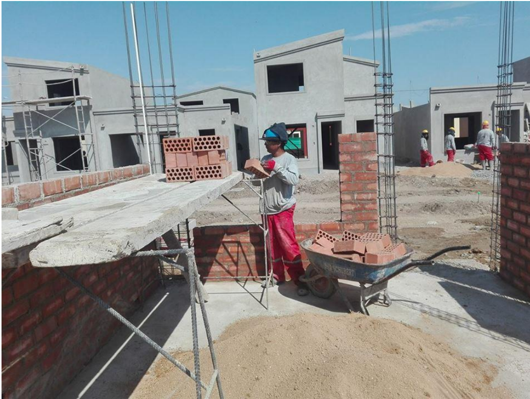
Fuente: Archivo de obra.
