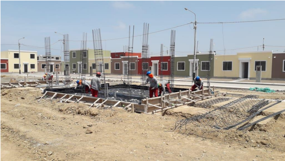
Fuente: Archivo de obra.
