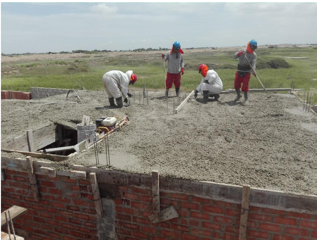
Fuente: Archivo de obra.
