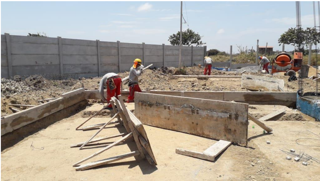
Fuente: Archivo de obra.
