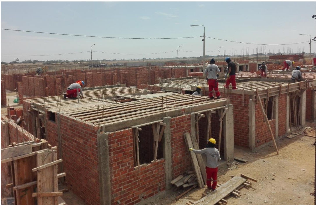
Fuente: Archivo de obra.
