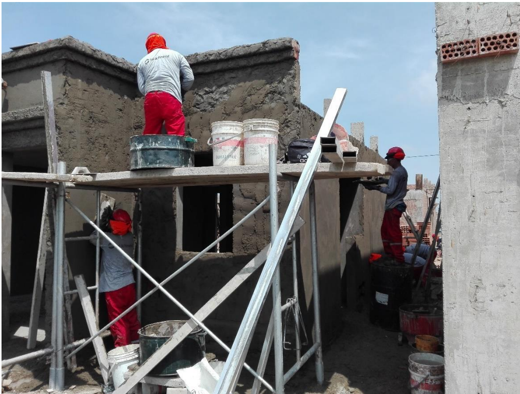
Fuente: Archivo de obra.
