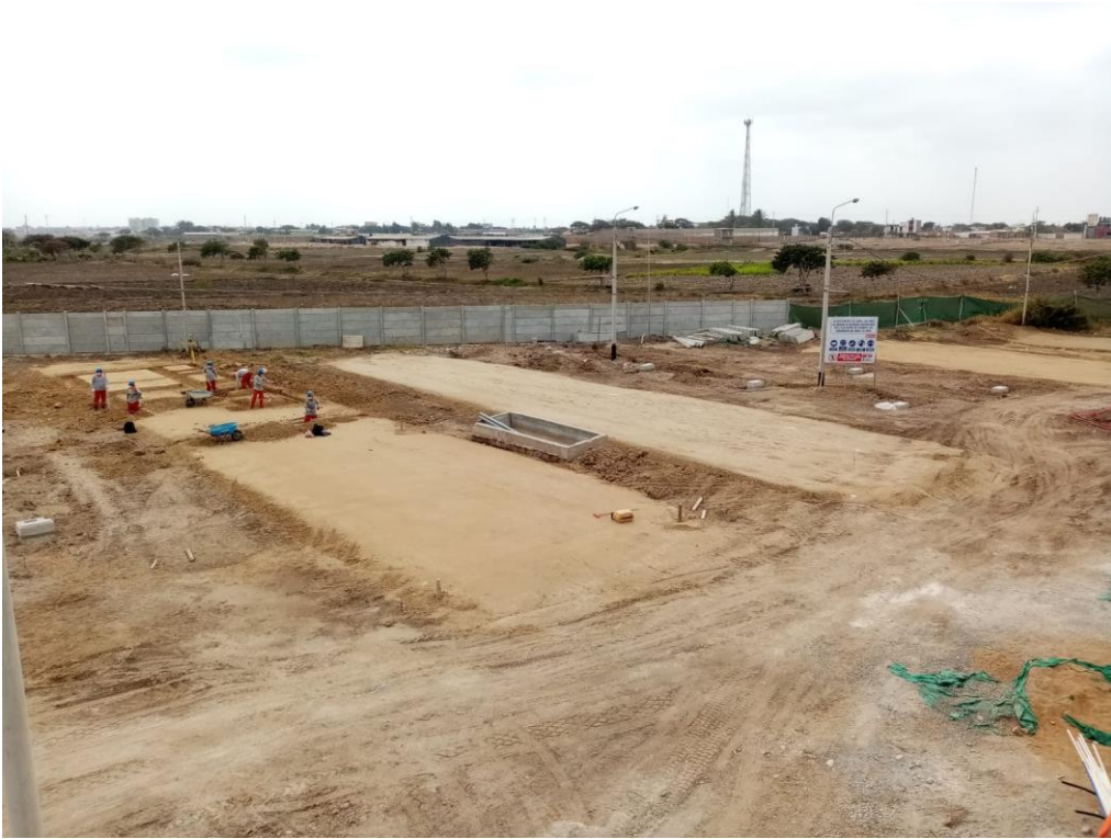
Fuente: Archivo de obra.
