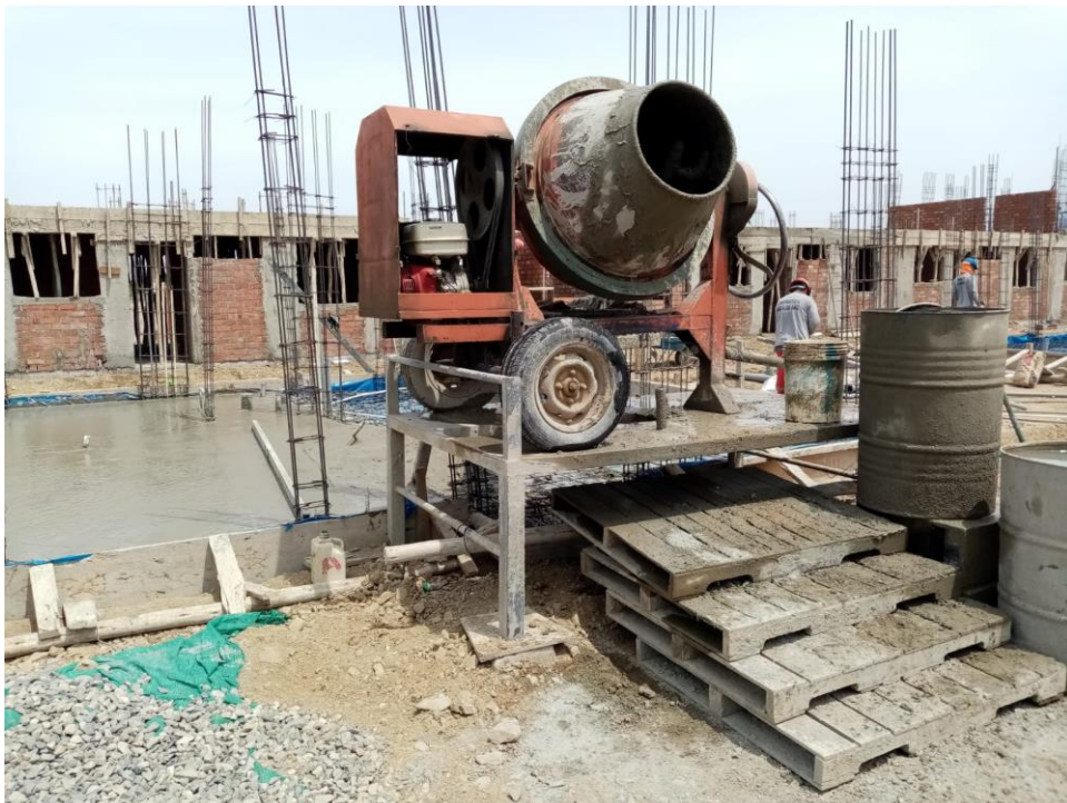
Fuente: Archivo de obra.
