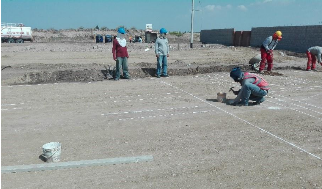
Fuente: Archivo de obra.
