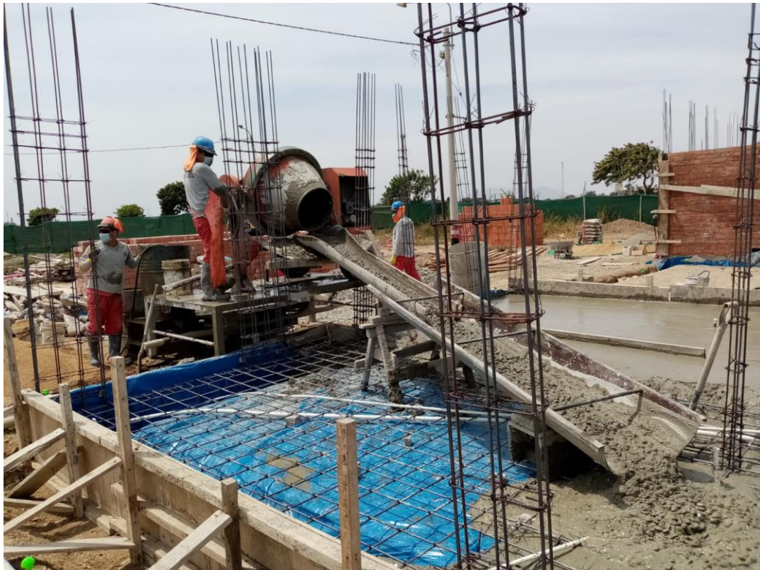
Fuente: Archivo de obra.
