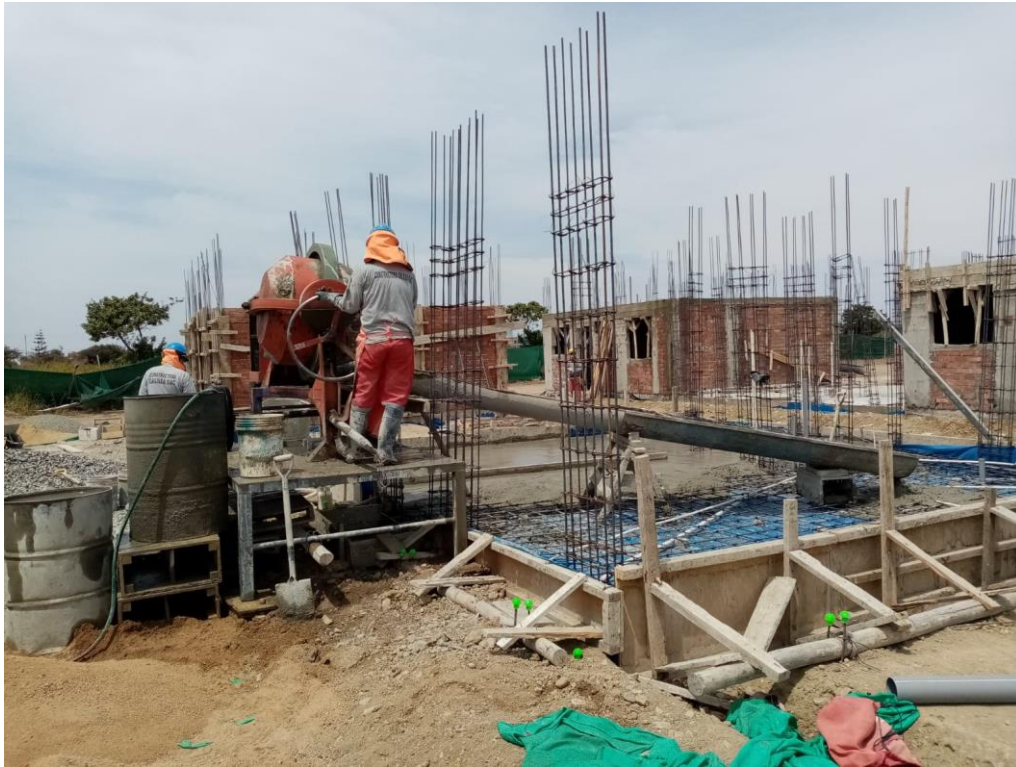
Fuente: Archivo de obra.
