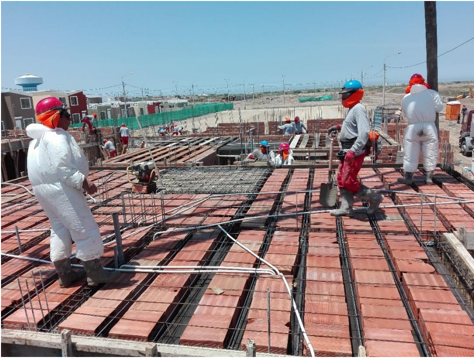
Fuente: Archivo de obra.
