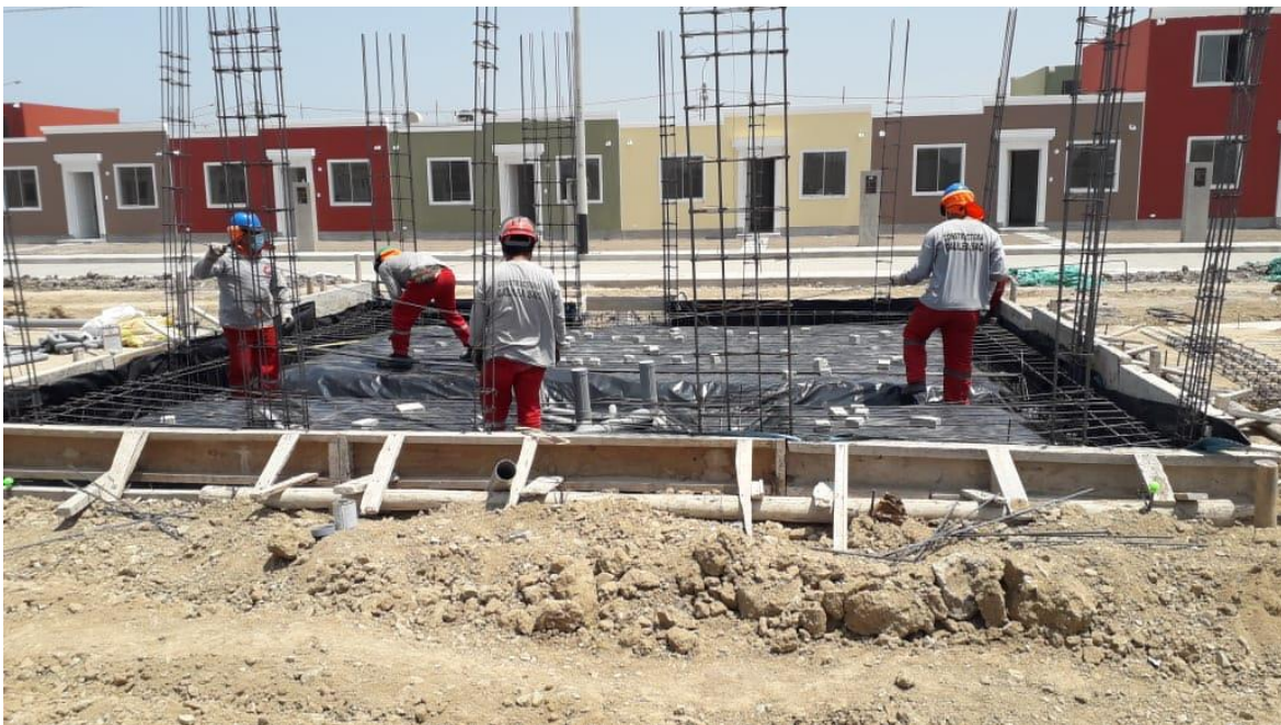
Fuente: Archivo de obra.
