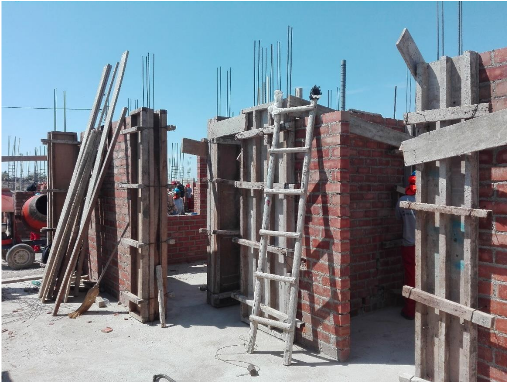
Fuente: Archivo de obra.
