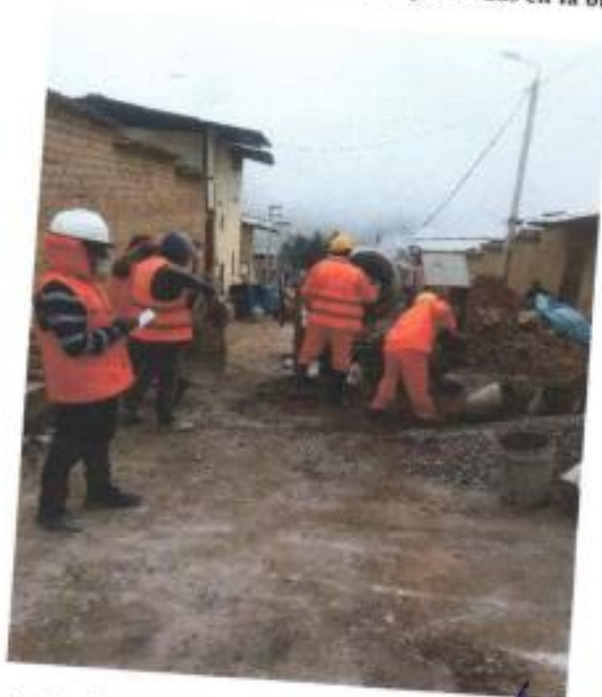
Toma de datos en las actividades ejecutadas en la obra.
