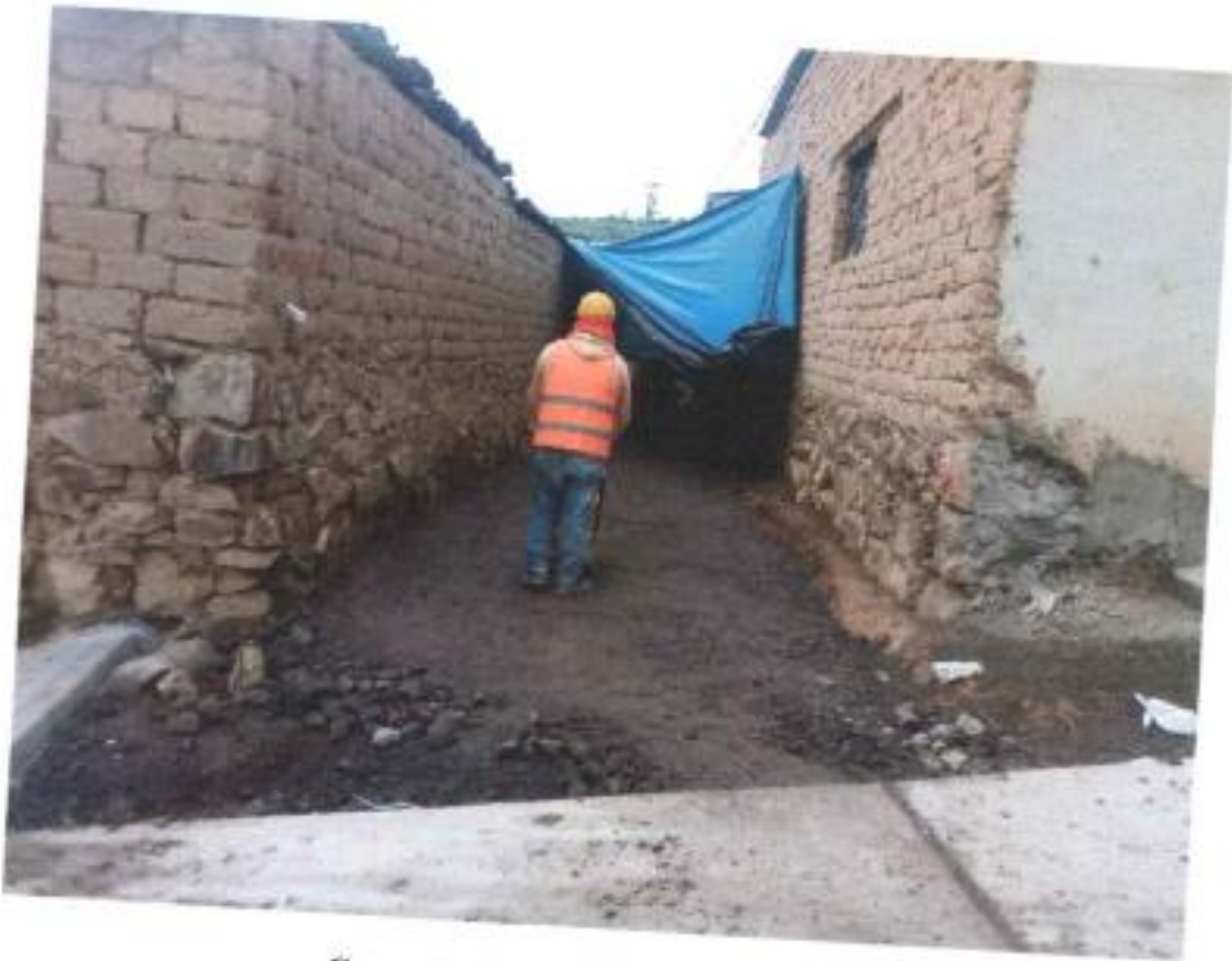
Compactación de base para pavimento.
