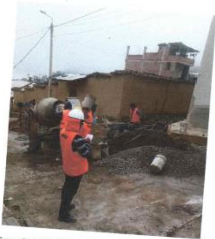
Toma de datos en las actividades ejecutadas en la obra.
