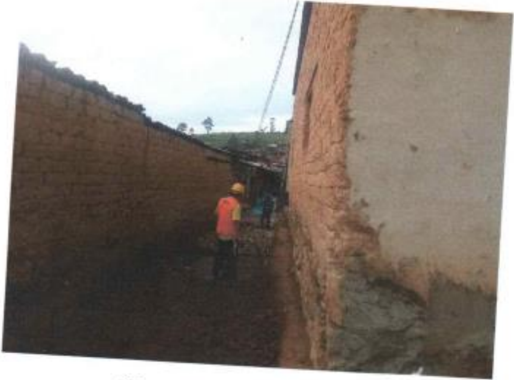
Colocación de Over para pavimento.
