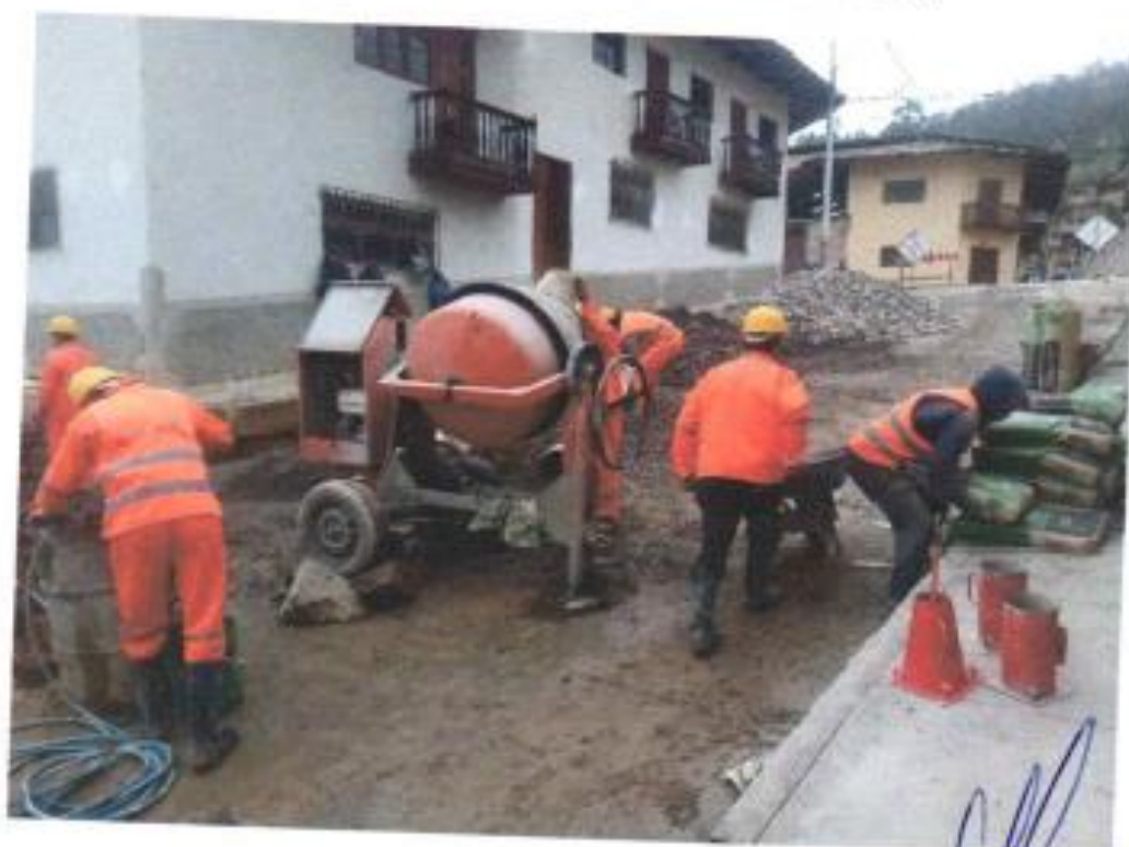
Elaboración de concreto f'c=175 \text{ kg/cm}^2 para vereda.
