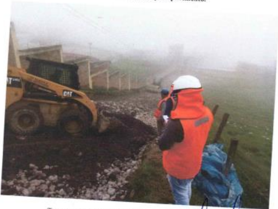
Toma de datos en las actividades ejecutadas en la obra.
