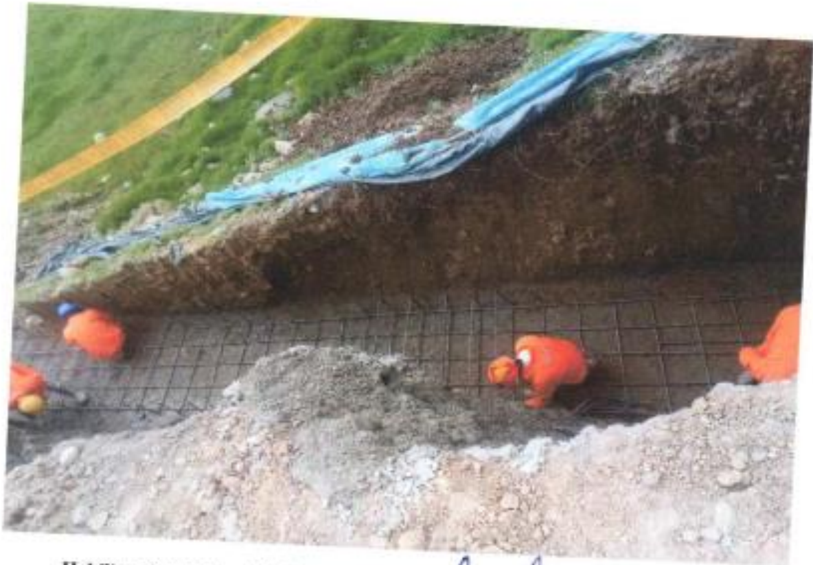
Habilitación y colocación de acero para la cimentación en muro de contención
