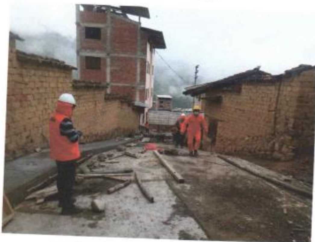
Toma de datos en las actividades ejecutadas en la obra.
