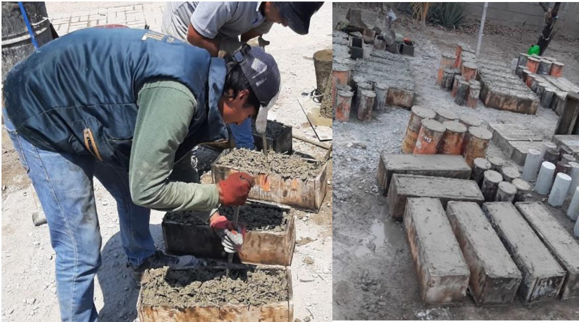
Fig. 104. Vaciado de probetas y vigas.
