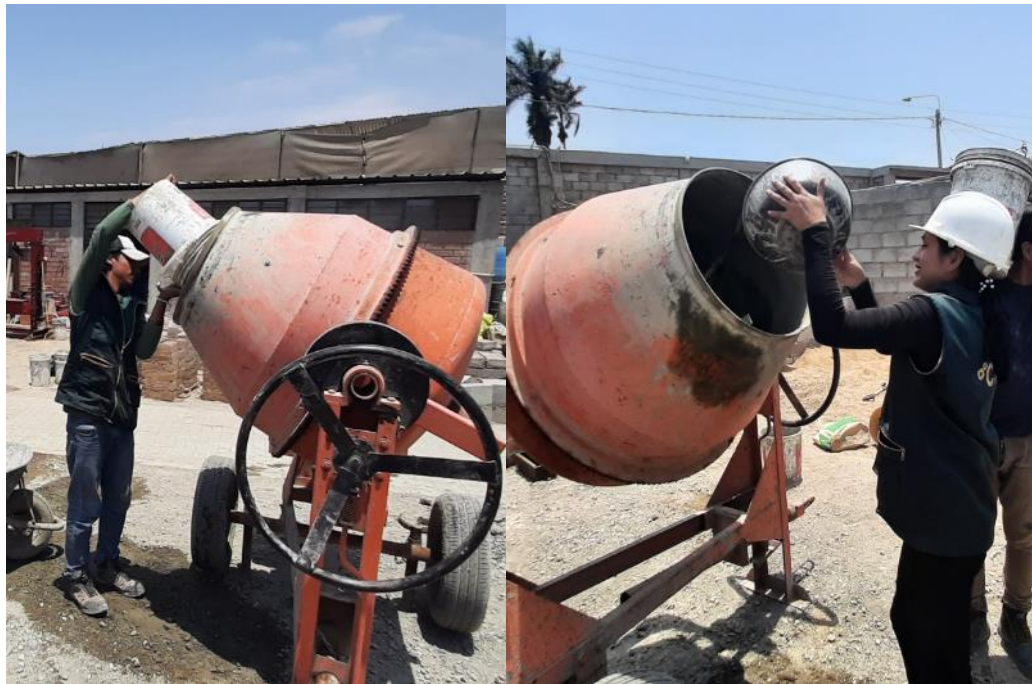
Fig. 99. Realización de la mezcla de concreto con caucho y PET reciclado.
