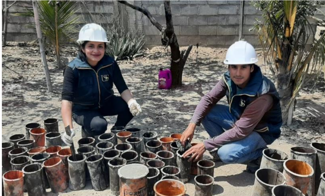
Fig. 89. Aplicación de aceite quemado a la superficie interior de los moldes.
