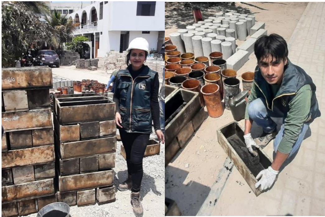
Fig. 98. Aplicación de aceite quemado a la superficie interior de los moldes.
