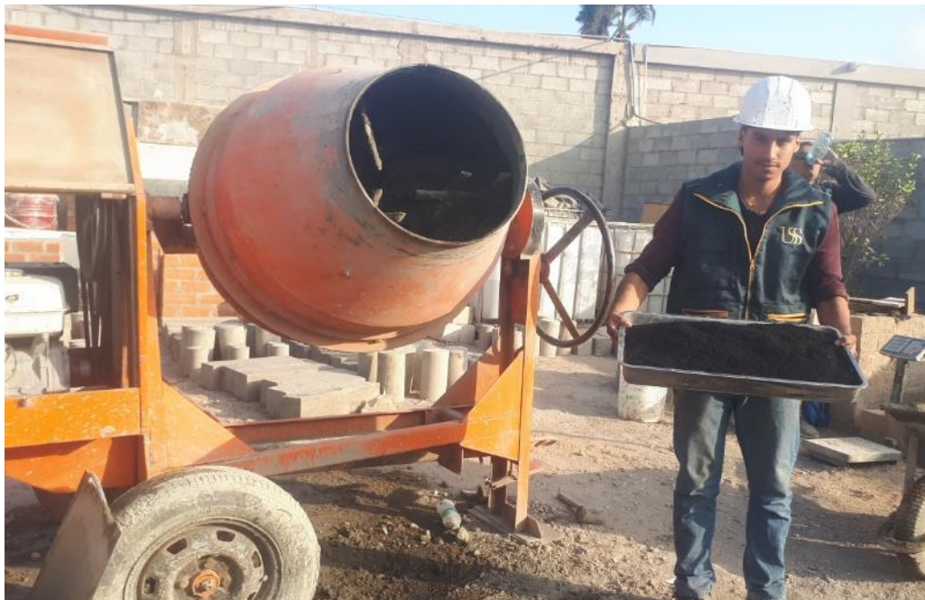
Fig. 90. Realización de la mezcla de concreto con caucho.
