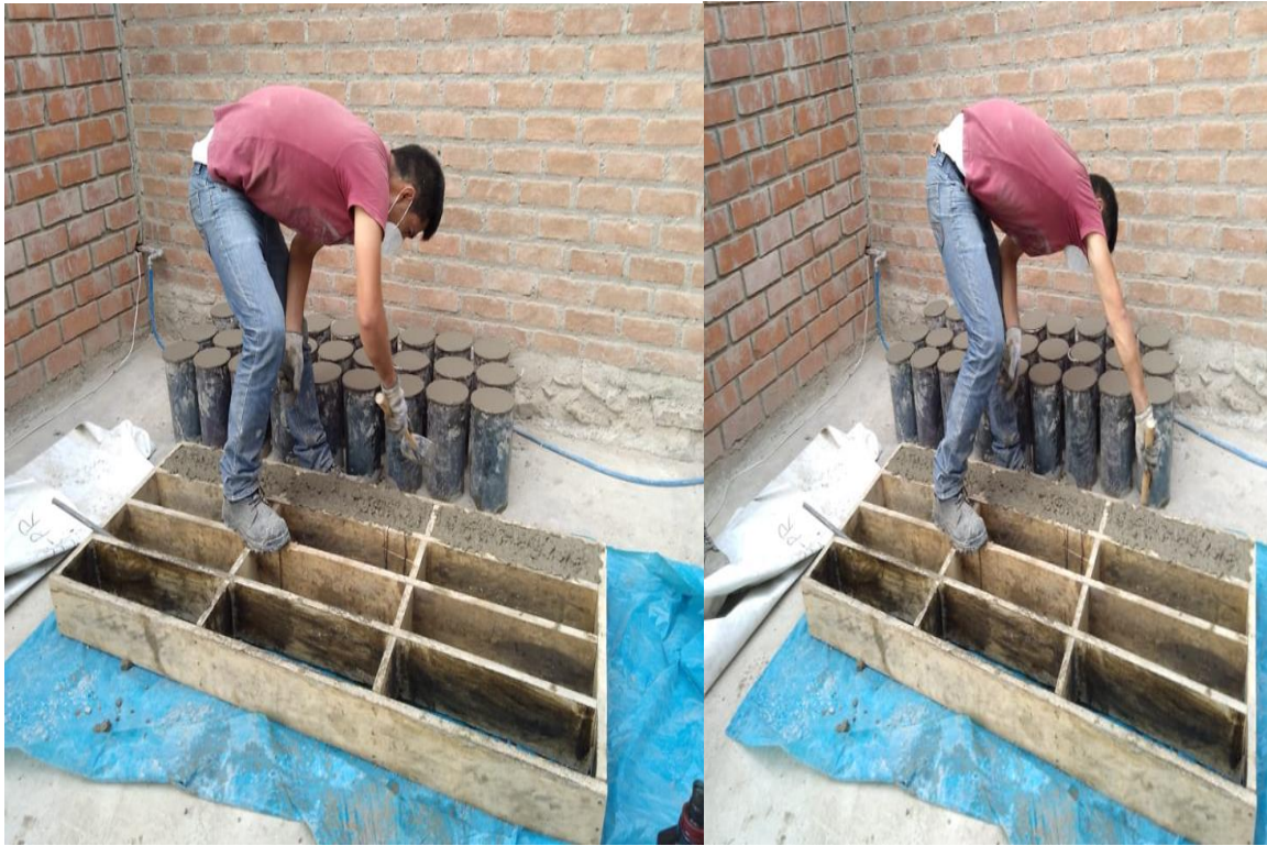
Foto 05: Elaboración de vigas para el ensayo a flexión
