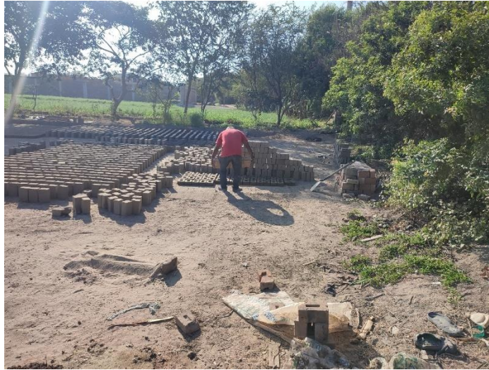
Foto 5: Moldeado y secado de ladrillos artesanales con concreto triturado (CT)
