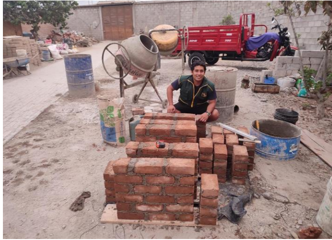
Foto 7: Construcción de pilas y muretes
