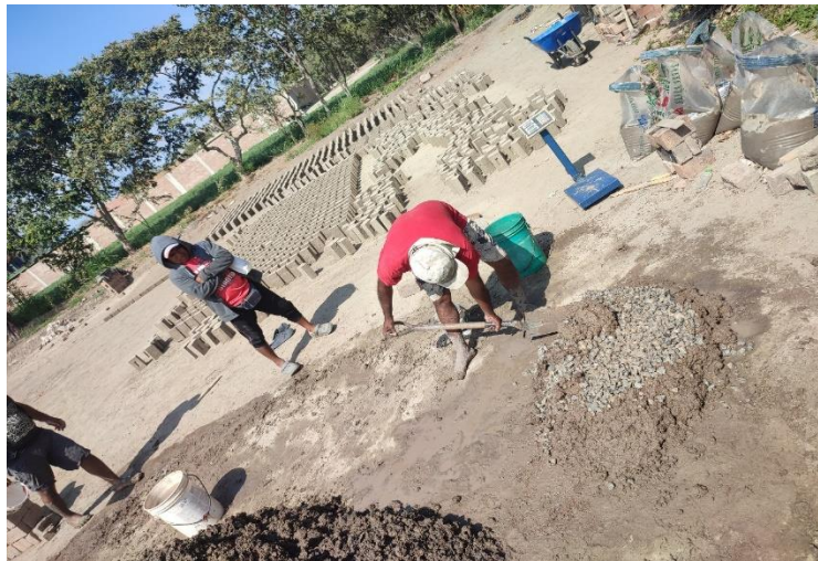
Foto 4: Mezclado de materia prima con concreto triturado (CT)
