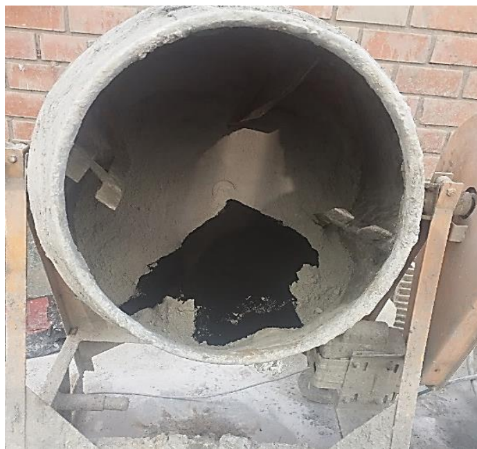
Foto N°05. Preparación de la mezcla de concreto adicionando caucho sintético
