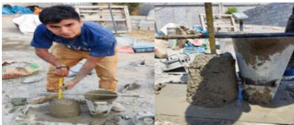
Fig. 23. Ensayo de SLUMP o ASENTAMIENTO.
