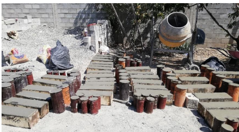
Moldeo de los testigos de concreto.
