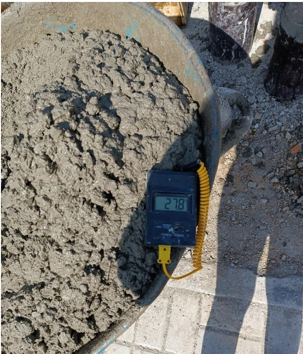
Ensayo de control de temperatura.
