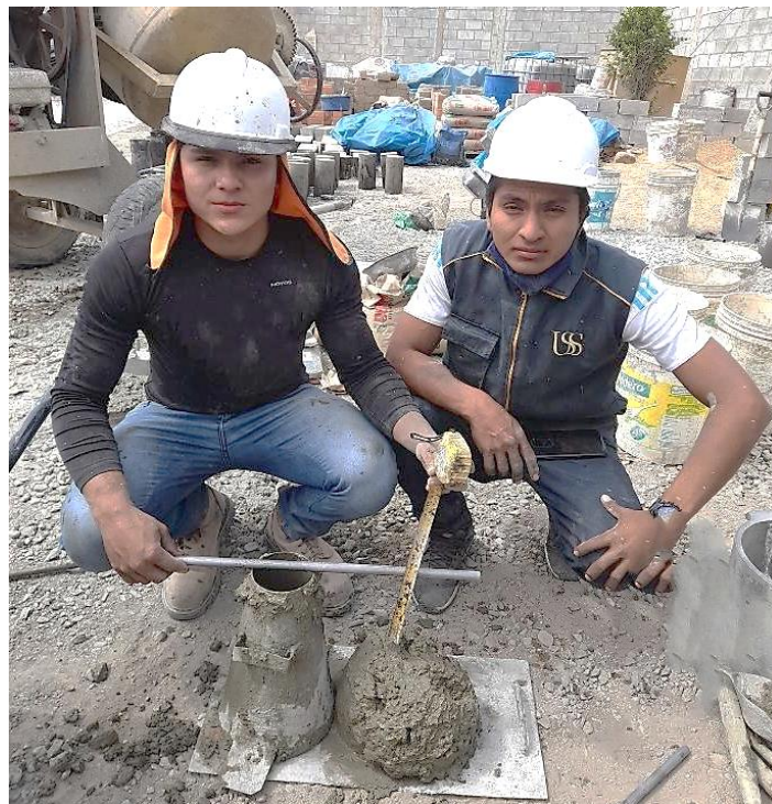
Fig. 58. Ensayo de asentamiento del concreto
