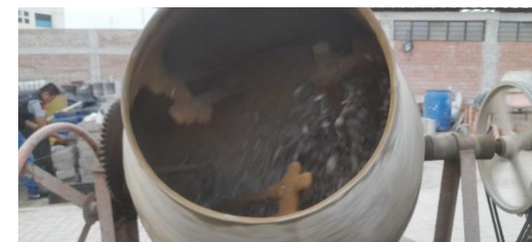
Fig. 66. Preparación de mezclas de concreto
