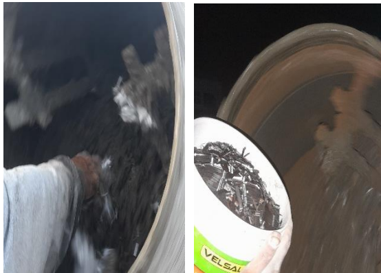
Fig. 67. Incorporación de las fibras a la mezcla.
