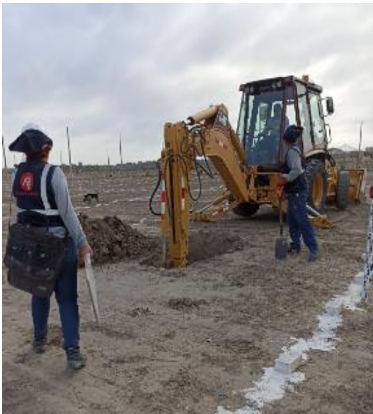
Fig. 5. Excavación de calicatas
