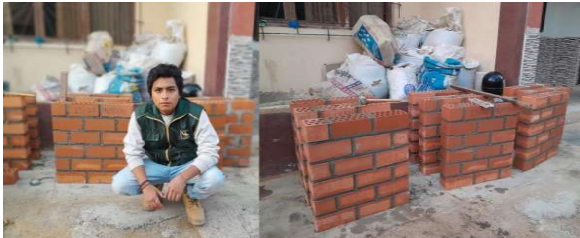
Elaboración de muretes de albañilería
