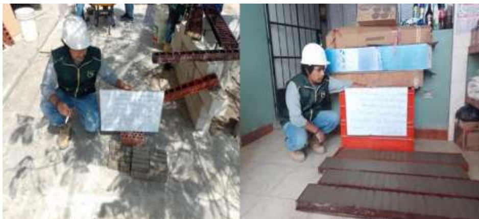
Elaboración de vigas
