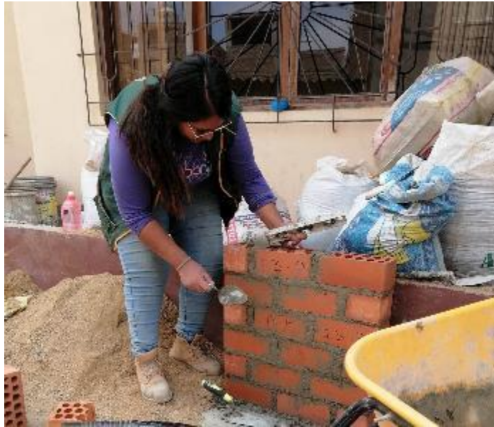
Fig. 41. Resistencia a la compresión diagonal en muretes
