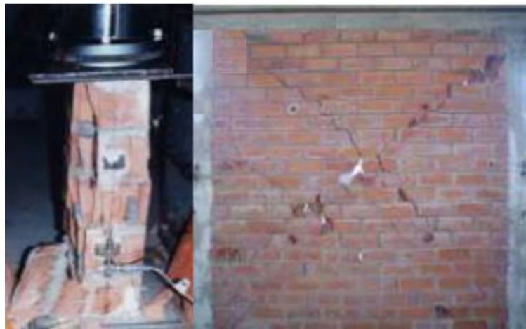
Fig. 6. Albañilería huecas - Falla en muro.
