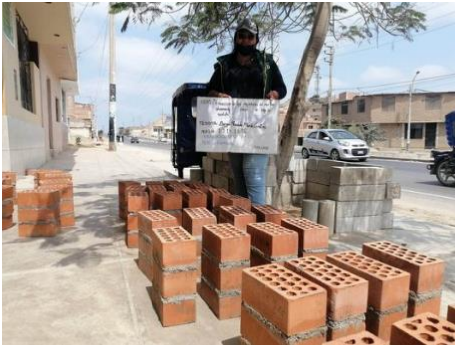
Elaboración de pilas de albañilería
