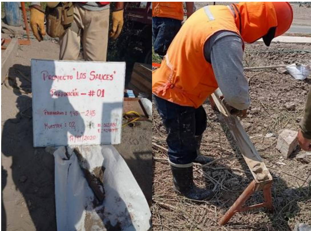
Toma de muestras perforación N-01 – Profundidad de 1.45 a 2.45 metros.
