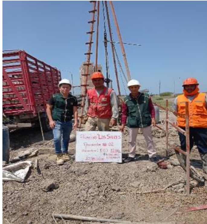
Fig. 11. Equipo de SPT para perforación N°2.
