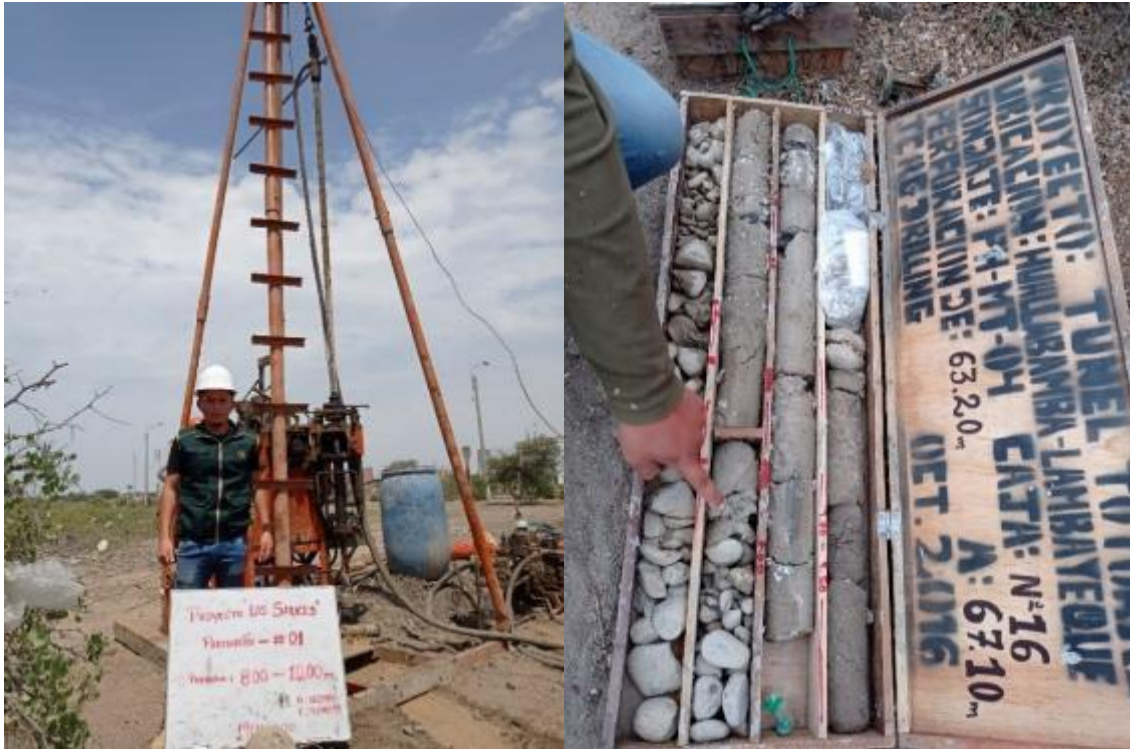
Toma de muestras perforación N-01 – Profundidad 8.00 a 10.00 metros
