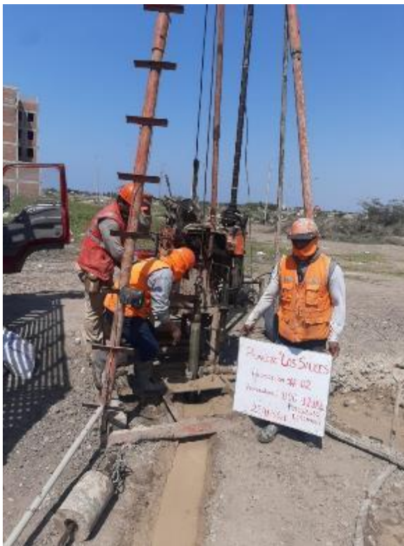
Toma de muestras perforación N-02 – Profundidad 12.00 a 14.00 metros
