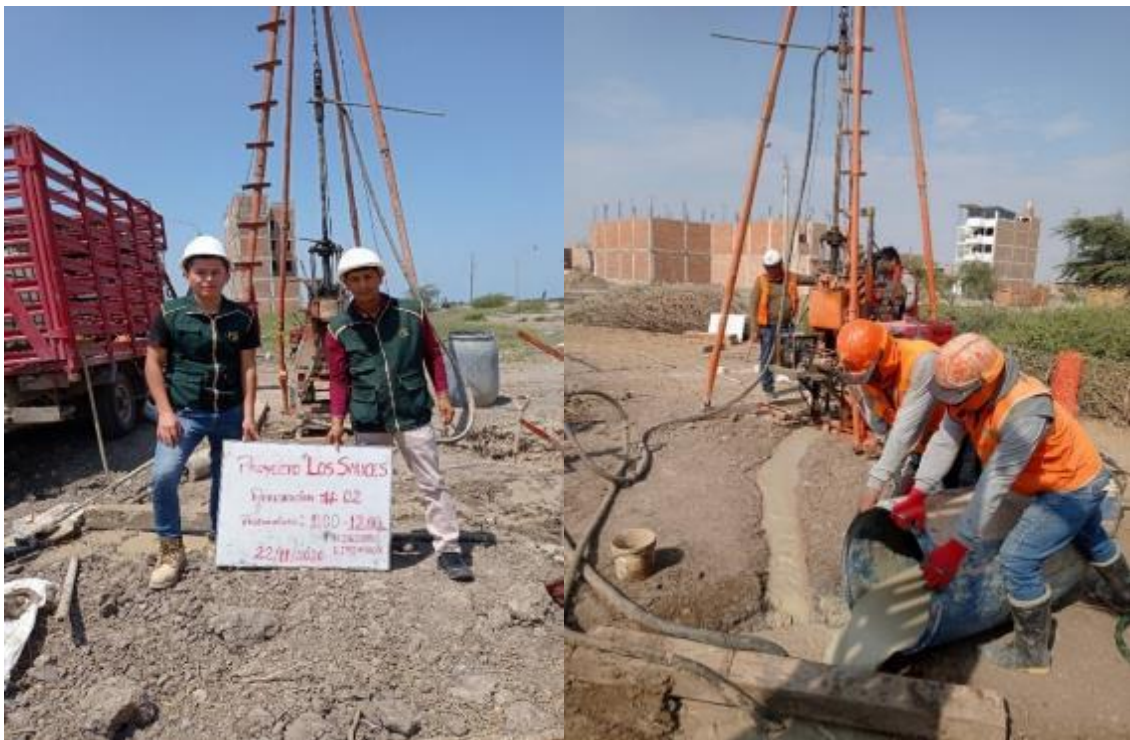
Toma de muestras perforación N-01 – Profundidad 10.00 a 12.00 metros
