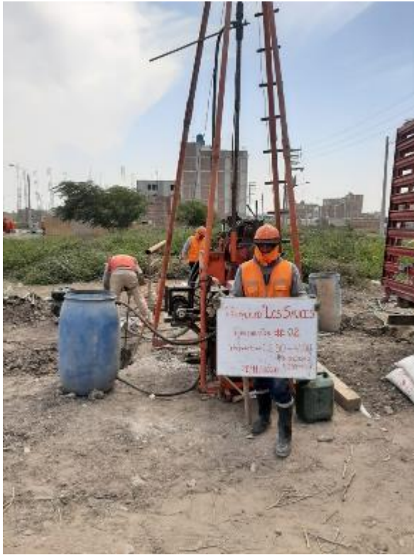
Toma de muestras perforación N-02 – Profundidad 2.50 a 4.00 metros
