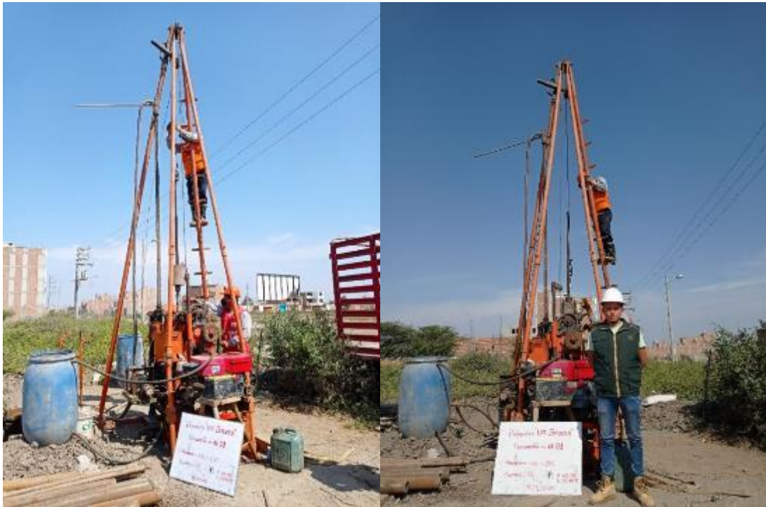
Toma de muestras perforación N-01
